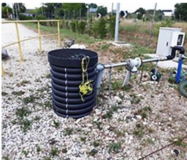
Figura 311. Particolare dell'impianto di raccolta percolato: pozzo di raccolta.
