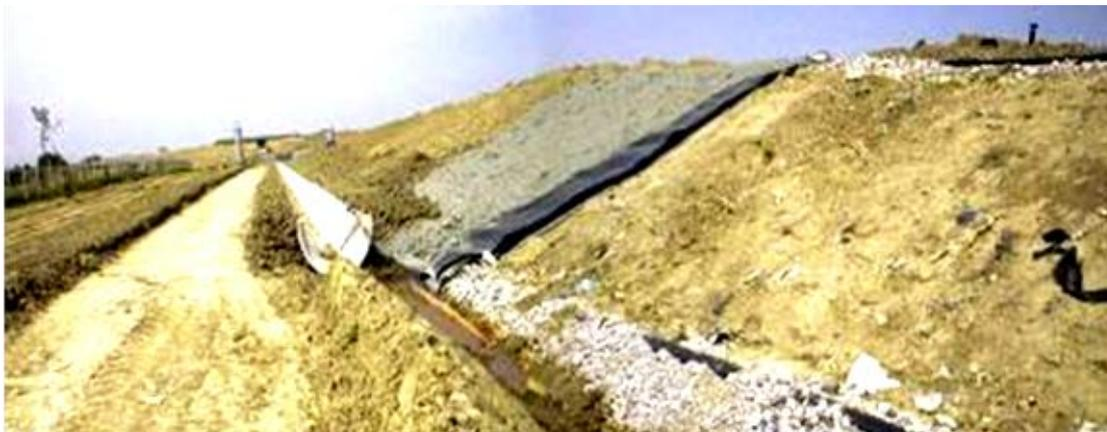
**Figura 33. Particolare di un argine di contenimento di una “vasca” in fase operativa. Si notano il sistema di impermeabilizzazione laterale con materiale HPDE ed argilla e la canaletta perimetrale di contenimento**
