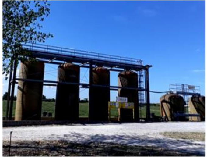
**Figura 27. Particolare dell'impianto di raccolta percolato: cisterne di stoccaggio.**
