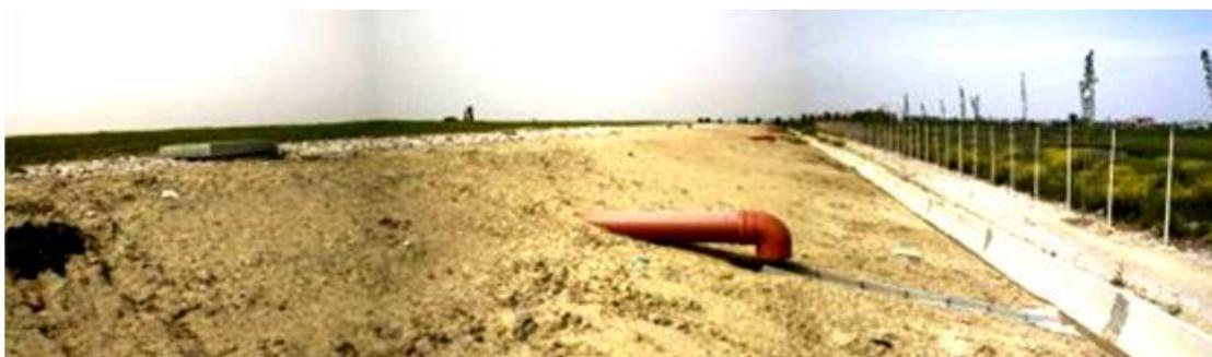
**Figura 34. Particolare del lotto C in fase di ultimazione : fiancata dell'argine di contenimento. Si notano i tubi di scarico delle acque piovane superficiali che provengono dai pozzetti di raccolta inseriti negli inghiottitoi superficiali, la canaletta perimetrale di contenimento delle stesse acque, la pista carrabile perimetrale di controllo, la recinzione e la barriera arborea che delimitano tutta la discarica**
