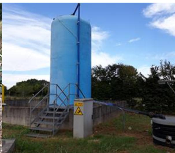
Figura 42. Particolare dell'impianto di raccolta percolato: cisterna di stoccaggio.
