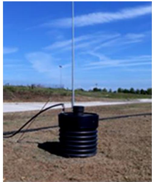
**Figura 298. Particolare dell'impianto di raccolta percolato: pozzo di raccolta.**
