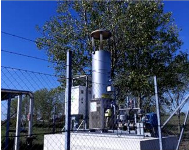
**Figura 265. Particolare dell'impianto di captazione biogas: torcia.**
