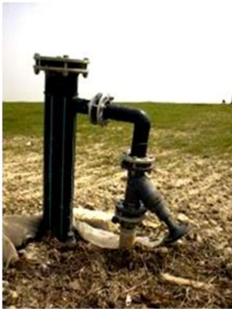
**Figura 28. Particolare dell'impianto di captazione biogas: pozzetto di raccolta.**
