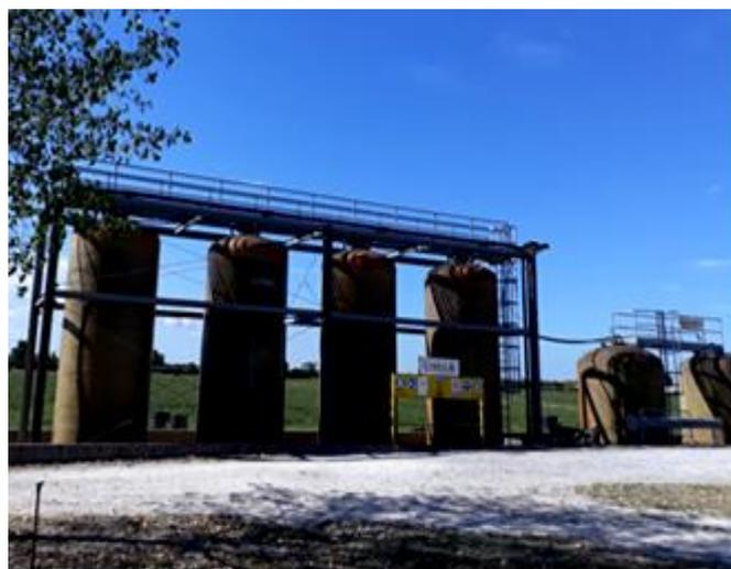
Figura 29. Particolare dell'impianto di raccolta percolato: cisterne di stoccaggio.
