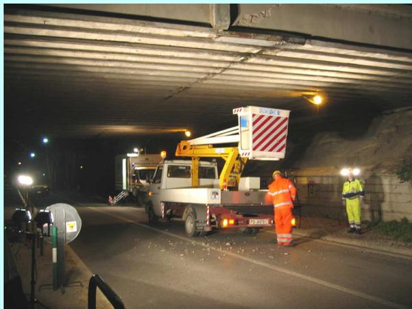
Lunedì 7 Maggio ore 19,45, squilla il cellulare del Coordinatore, c'è un'emergenza: un camion ha danneggiato un'arcata del sottopasso dell'autostrada in via Vigonovese. La viabilità è interrotta, mentre i tecnici dell'autostrada fanno i rilievi di staticità del manufatto. Data l'ora fra poco ci sarà la necessità di illuminare la zona.
