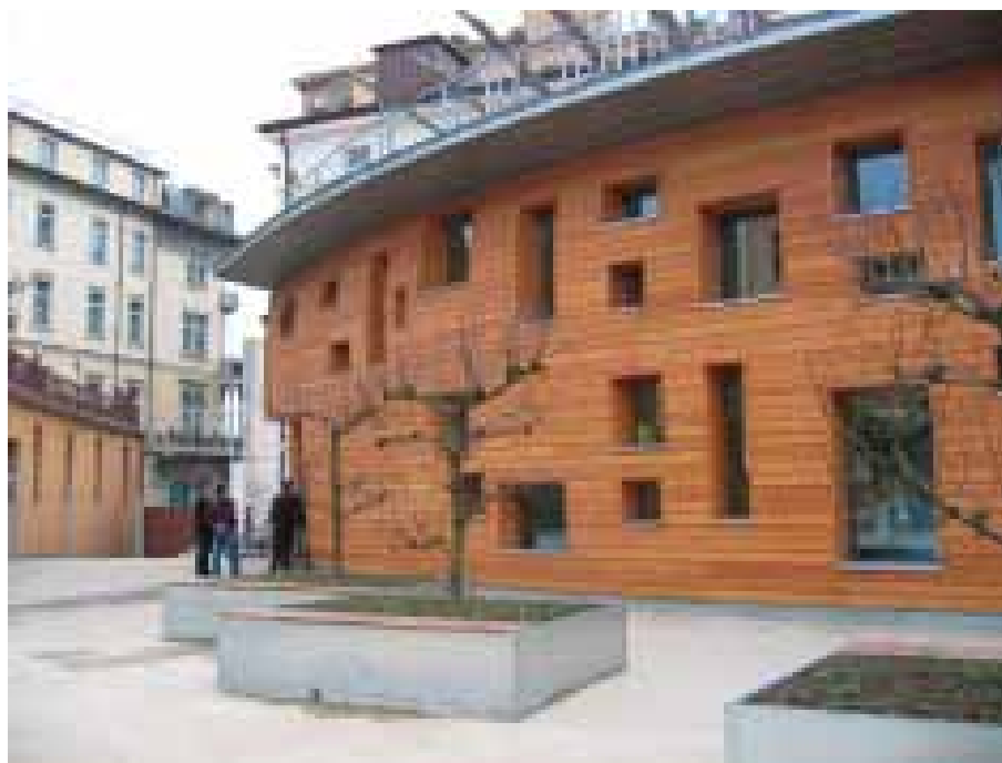
FOTO BANCA ETICA - FONTE: http://www.tamassociati.org/CANTIEREBPE/PAGES/HOME/home.html
