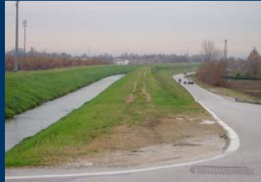
Sommità arginale prima dei lavori in località Loreggia.
