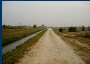
Sommità arginale durante i lavori in località Boscalto.
