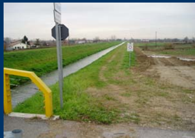
Sommità arginale prima dei lavori in località Boscalto.
