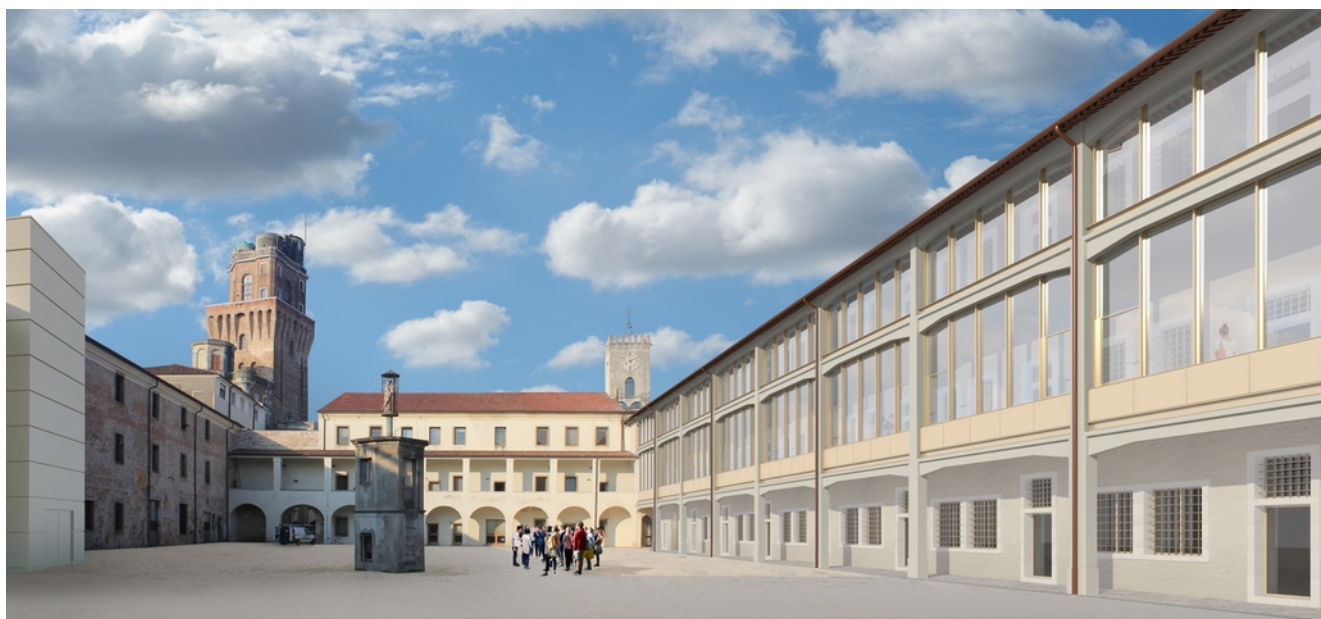
36_ il serramento in acciaio della facciata sud all'interno del telaio in c.a.: vista verso la Specola a ovest
