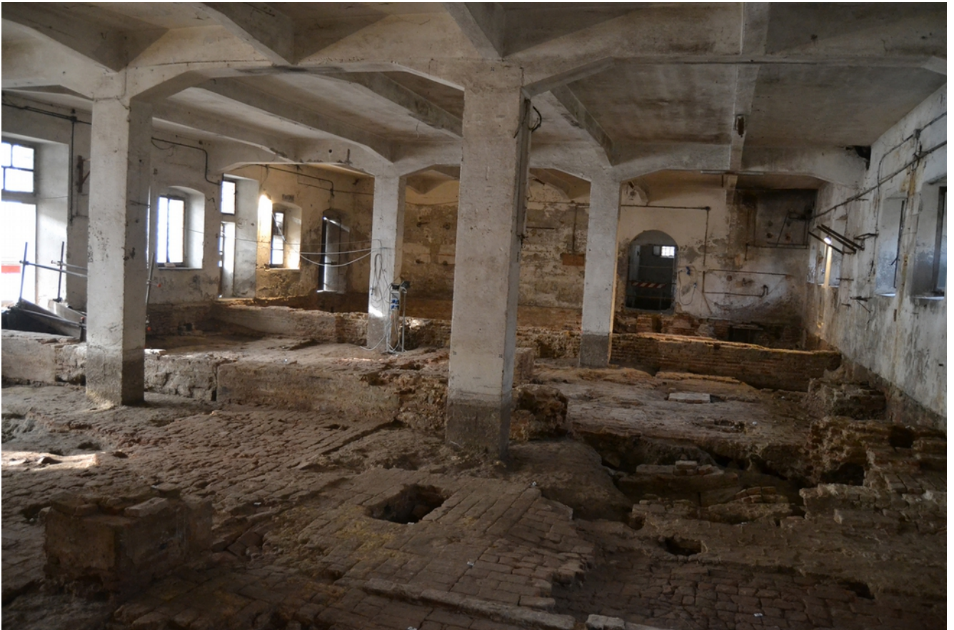
13_fotografia di sala 00.108 al piano terra, dove si vedono i nuovi impalcati novecenteschi in c.a. a soletta piena e gli spiccati delle murature carraresi emerse dalla campagna di scavo del 2014
