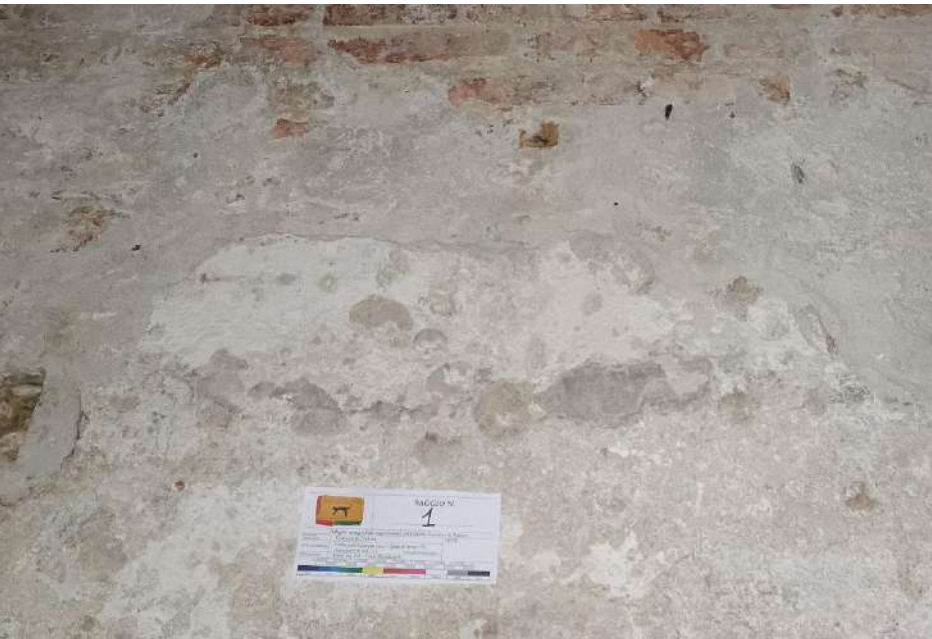
F02: dettaglio intonaco saggio S01
