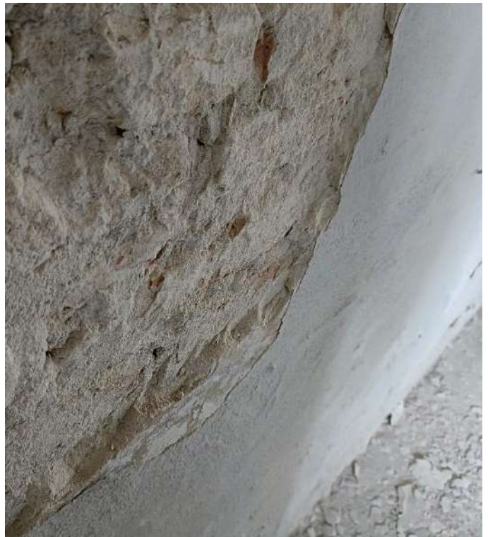
F19: dettaglio intonaci saggio S07
