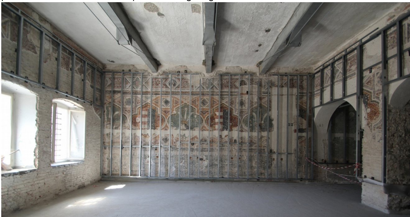
29_sala 01.033, parete ovest, stato attuale con le strutture per la protezione delle decorazioni.
