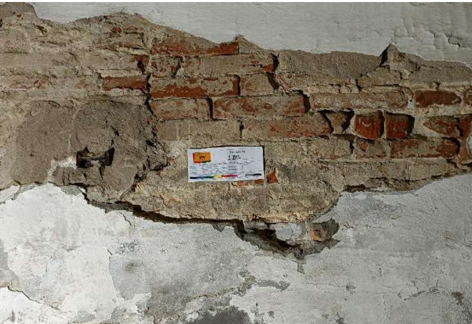
F04: dettaglio intonaco saggio S01bis
