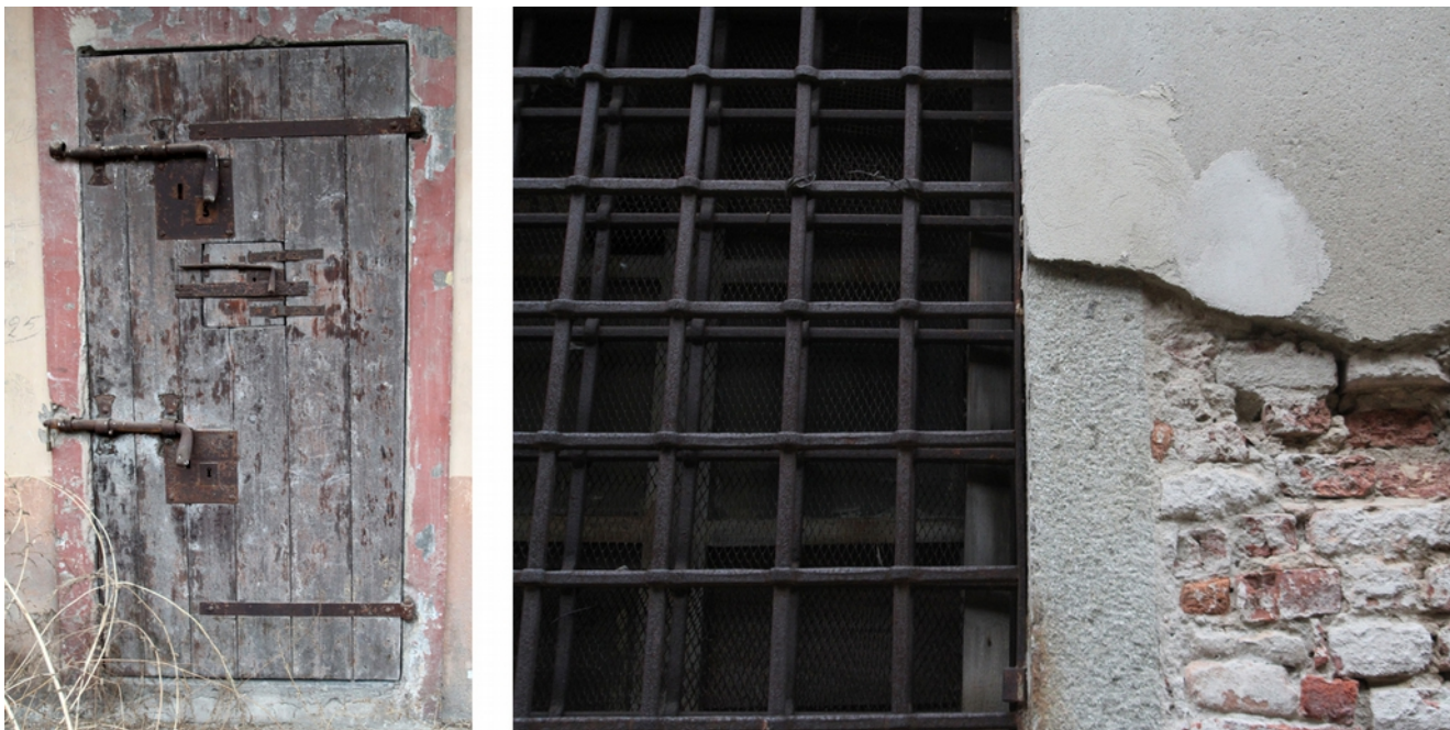
35_portone ligneo di facciata sud; inferriata doppia dei varchi del fronte nord
