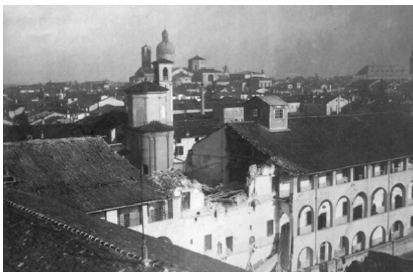
08_ Il bombardamento aereo del 1918 colpisce la parte occidentale dell'ala nord
