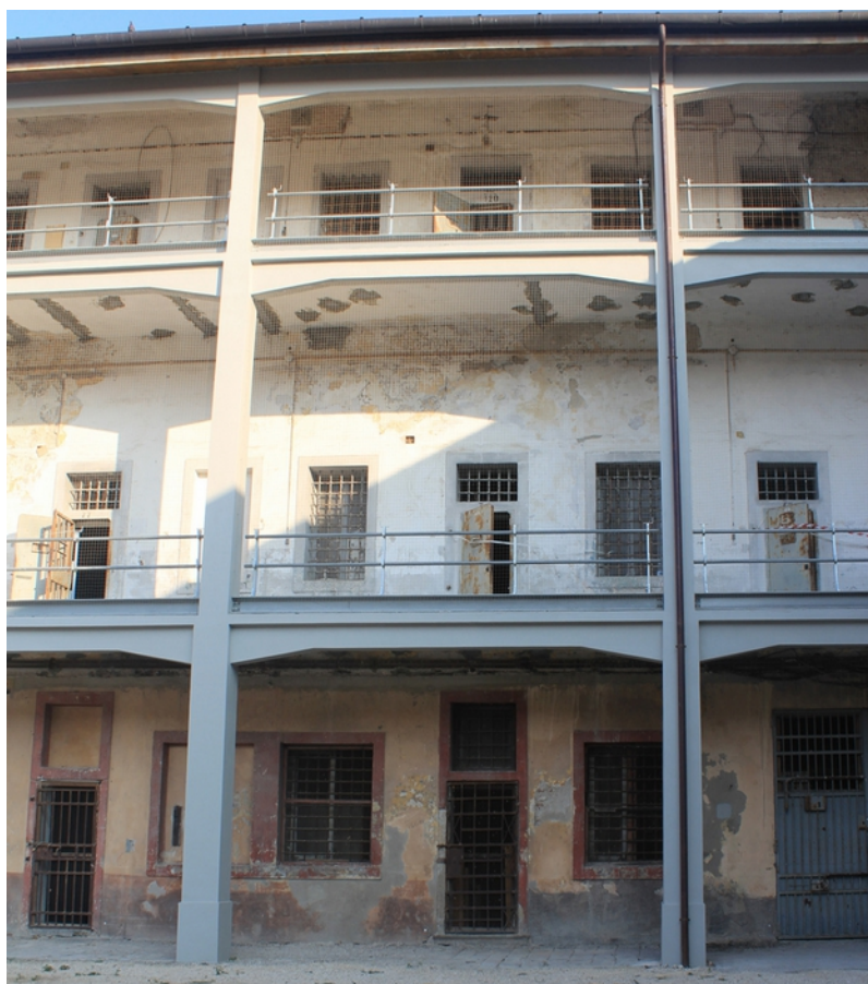
34_ sezione del prospetto sud e particolare delle cornici in malta cemento stesa sulla trachite
