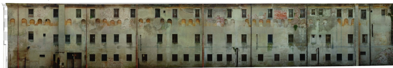
11_ fotopiano della facciata nord (2014)
