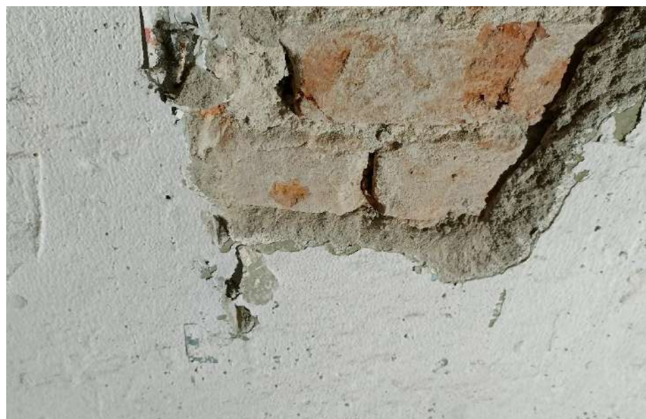
F08: dettaglio intonaci saggio S02
