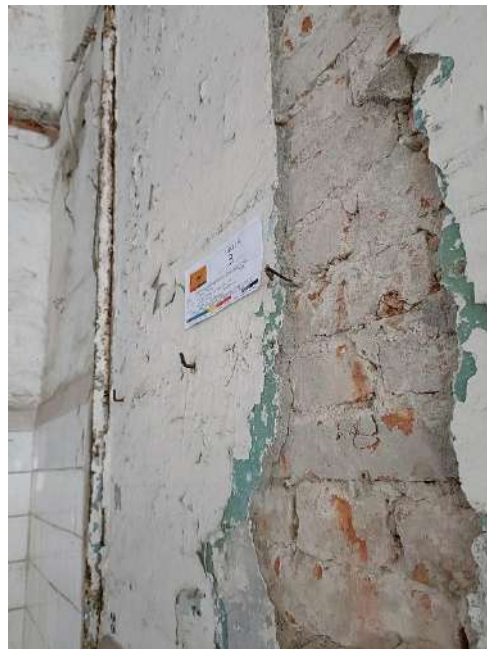
F15: dettaglio stratigrafia intonaci saggio S03
