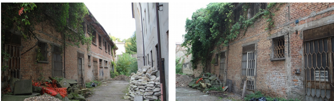
40_fotografie dell'edificio nord, stato attuale; a sinistra verso est, a destra verso ovest, con il muro delle celle di rigore
