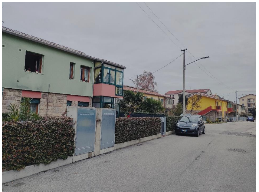
Figura 5 – Vista su via Curie da edificio di via Curie 25
