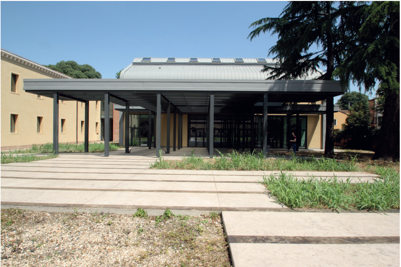
2. il portico del lapidario e il nuovo edificio dei servizi visti dal laboratorio di restauro
