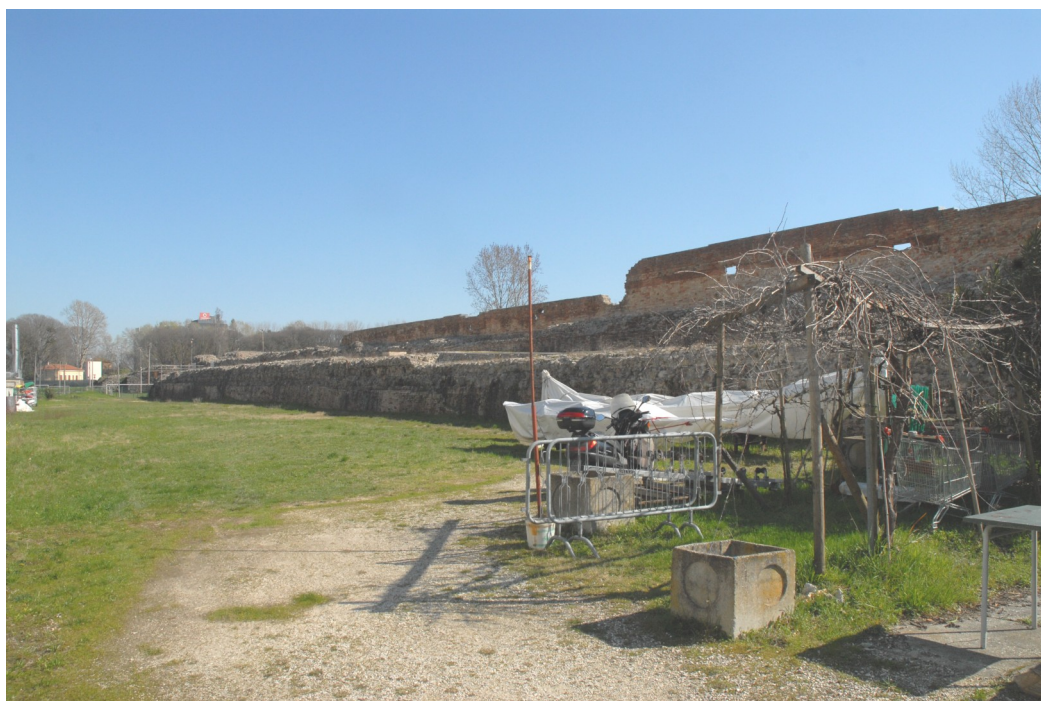
FOTO 10 - Il tratto nord del percorso di ronda visto da sud-ovest
