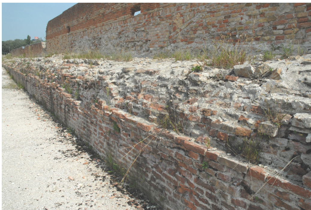
FOTO 14 - Dettaglio della tessitura muraria delle mura
