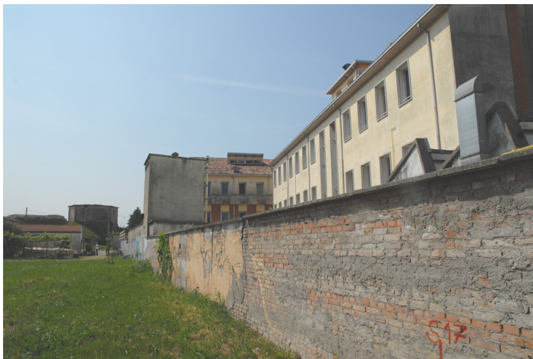
FOTO 19, 20 - Recinzione occidentale dell'area d'intervento, vista verso nord e verso sud
