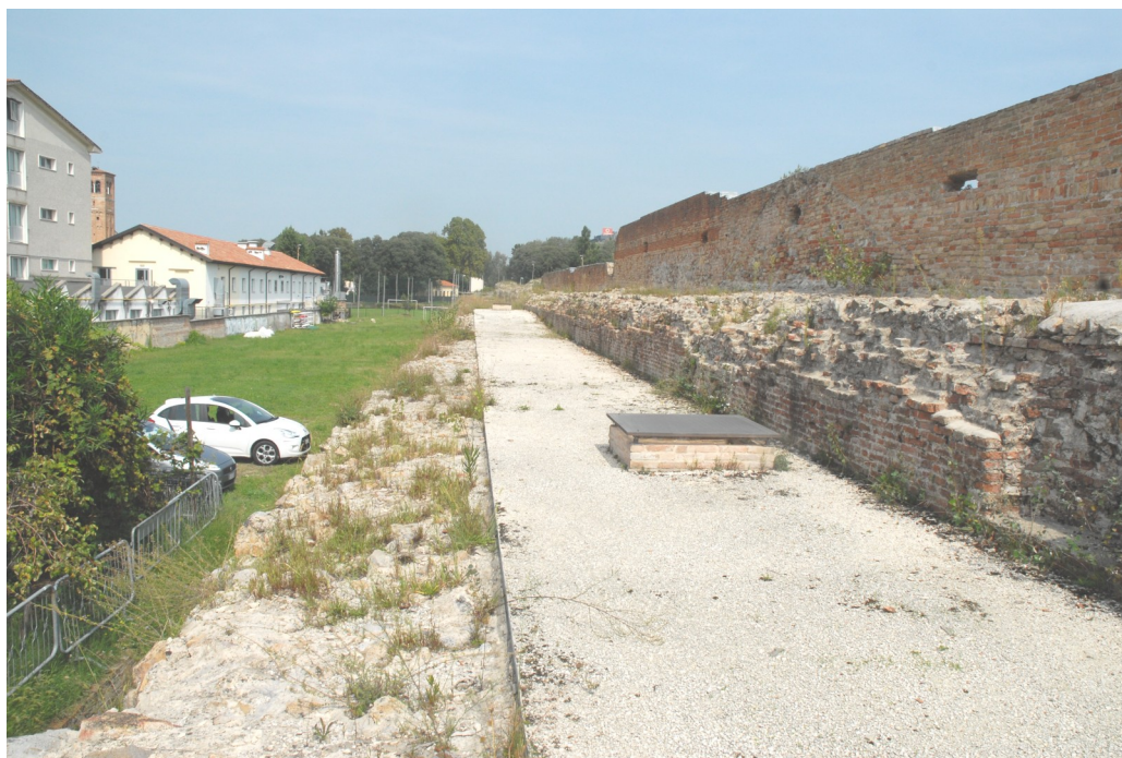
FOTO 13 - Il percorso di ronda visto da sud, con i camini che forniscono luce e aria al percorso ipogeo sottostante
