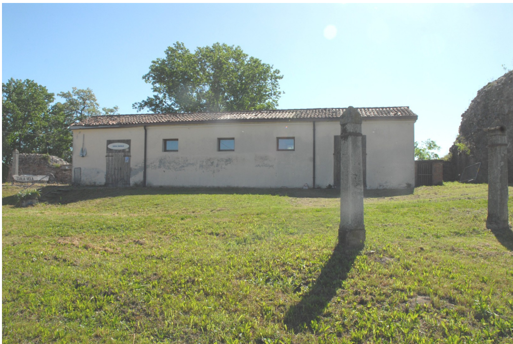
FOTO 8 - Il prospetto ovest dell'edificio della Lega Navale
