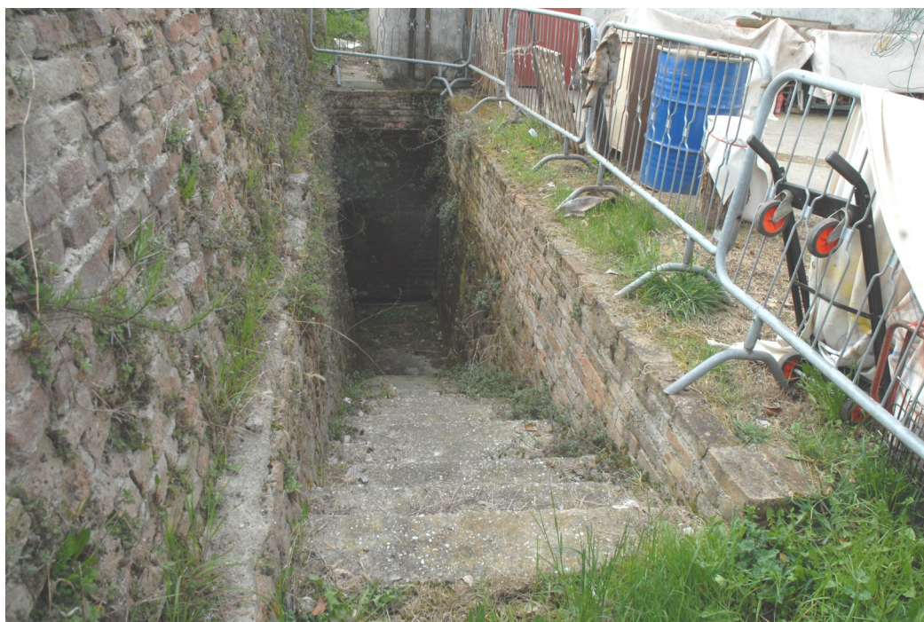
FOTO 12 - La scala di accesso sud-ovest al percorso ipogeo sotto la cortina
