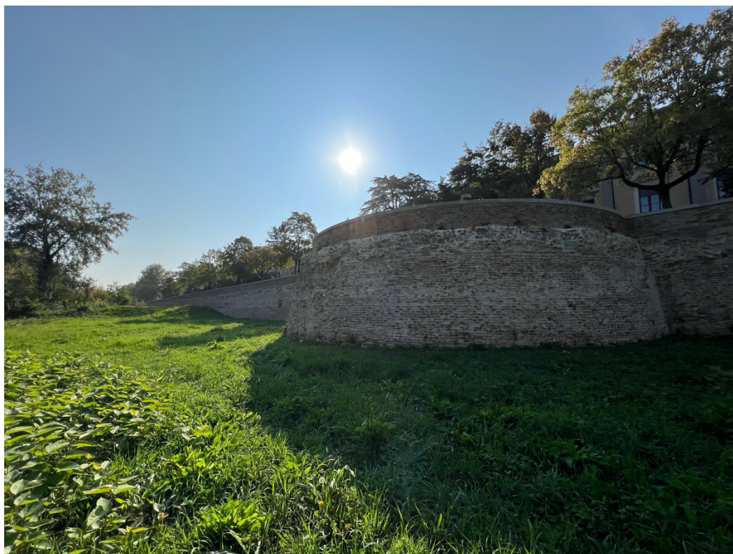
2_Vista dell'area dal piano golenale verso Est
