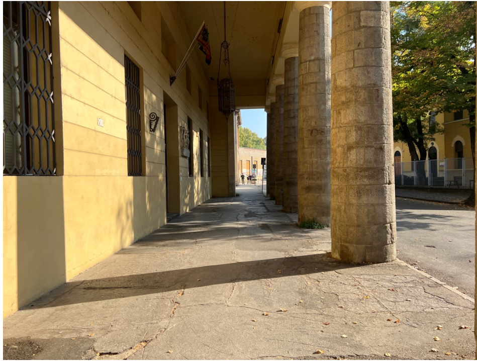
13_Vista del tratto di marciapiede sotto il pronao d'ingresso alla scuola direzione Est
