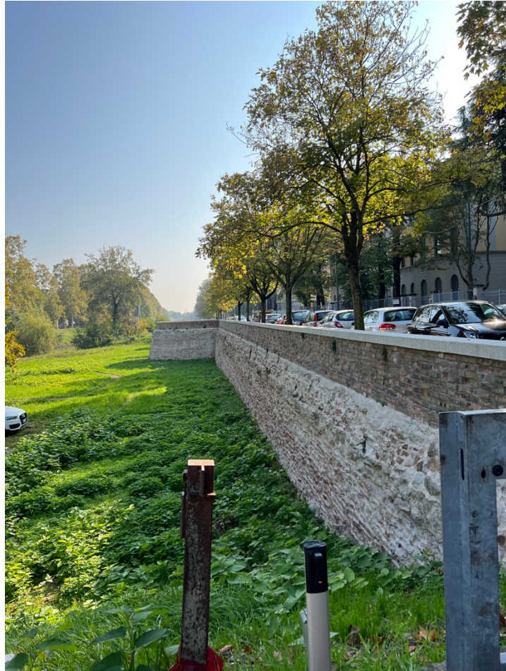
1_Vista dalla rampa verso Est
