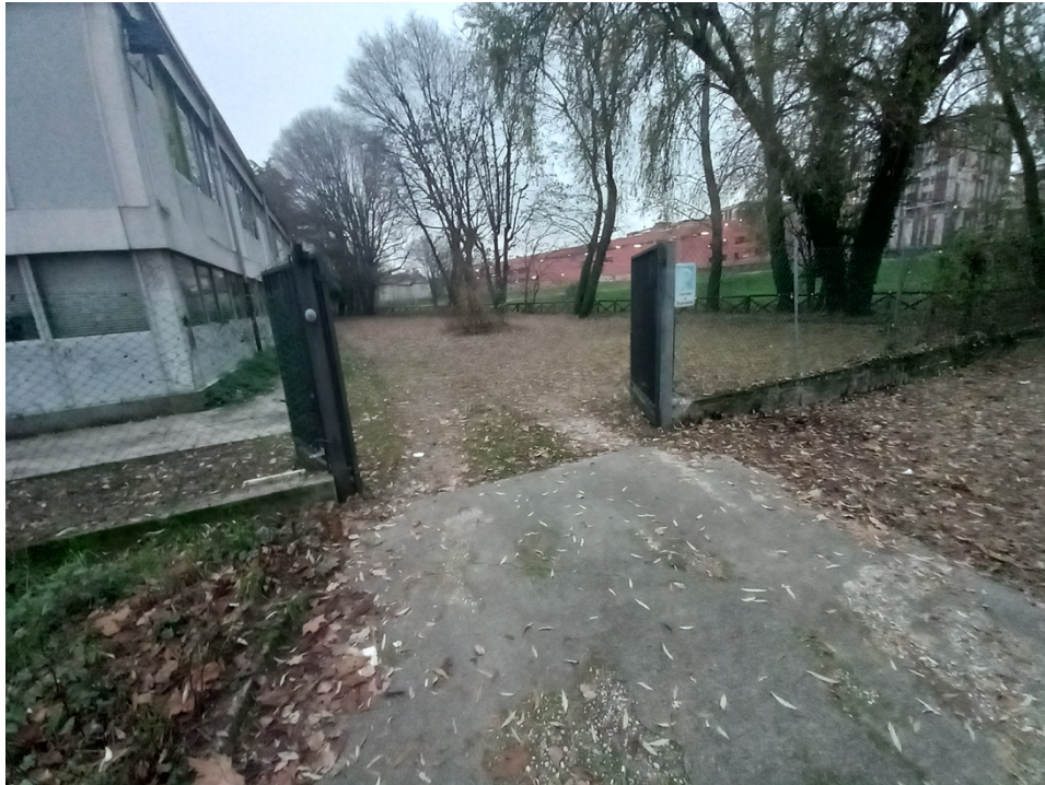
7_Vista della recinzione dell'accesso carrabile alla scuola ai piedi della rampa direzione Ovest
