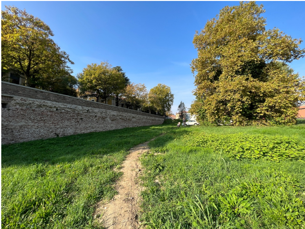
6_Vista dell'area di intervento e della cinta muraria in direzione Ovest
