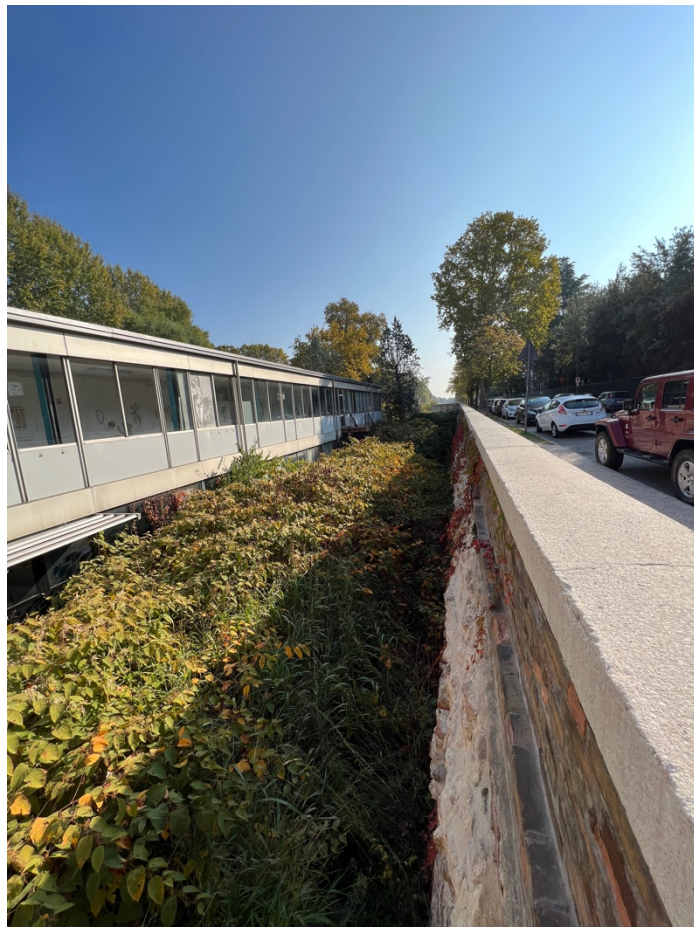
16_Vista del corpo di fabbrica degli anni '60 parallelo alle mura in prossimità della rampa di discesa all'area golenale
