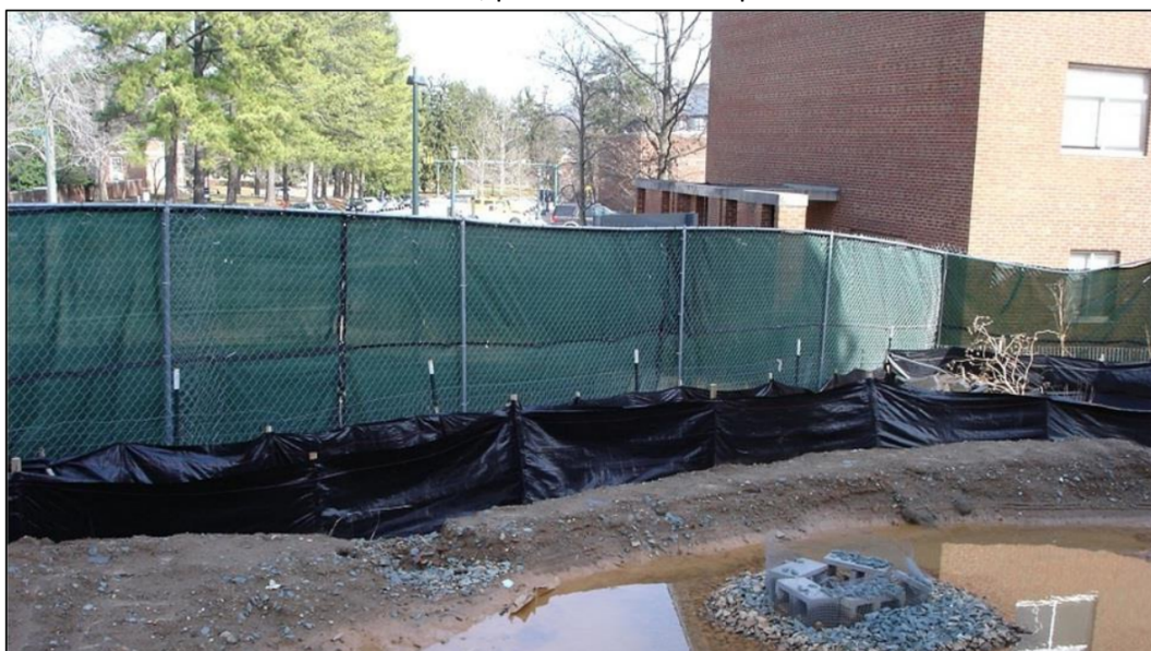
5 - Esempio di contenimento dei sedimenti in area di cantiere. Fonte: http://ehs.virginia.edu/ehs/ehs.esc/examples.html
