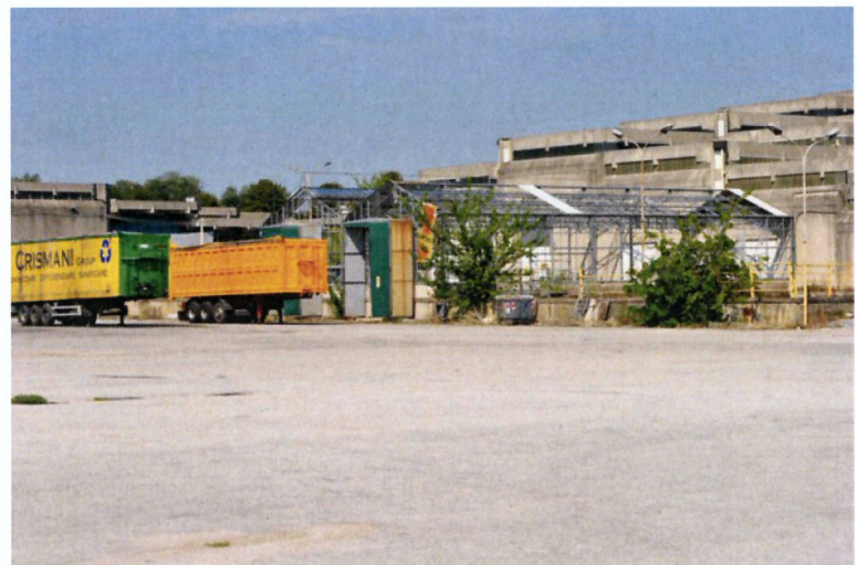
Stazione L, foto 0863
