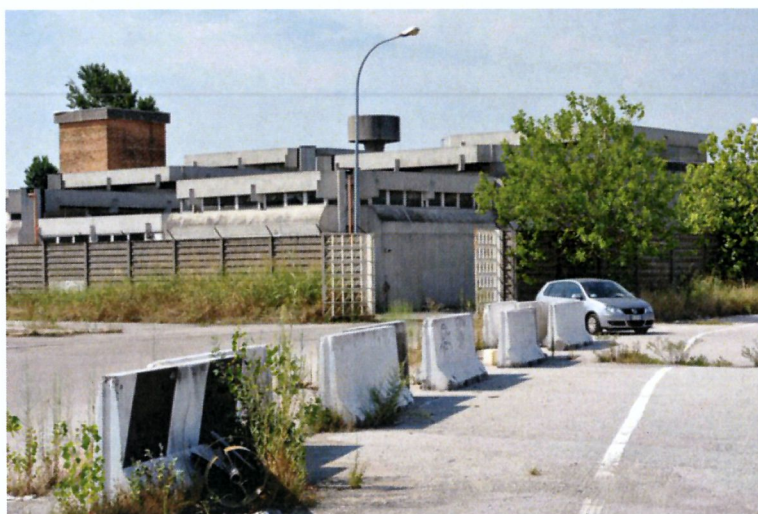
Stazione L, foto 0859
