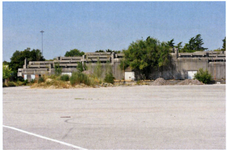
Stazione L, foto 0861
