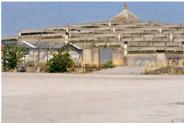
Stazione L, foto 0864
