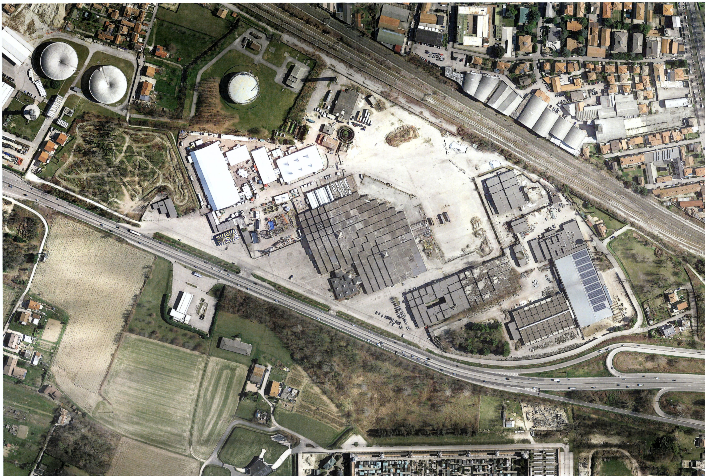
VISTA ZENITALE - STATO DI FATTO
