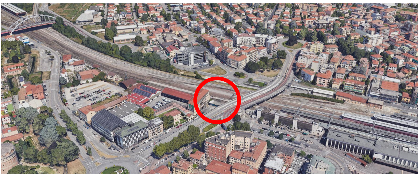
Figura 2 – Vista dall'alto. In rosso l'area di progetto edificio Casetta Eremitano.
