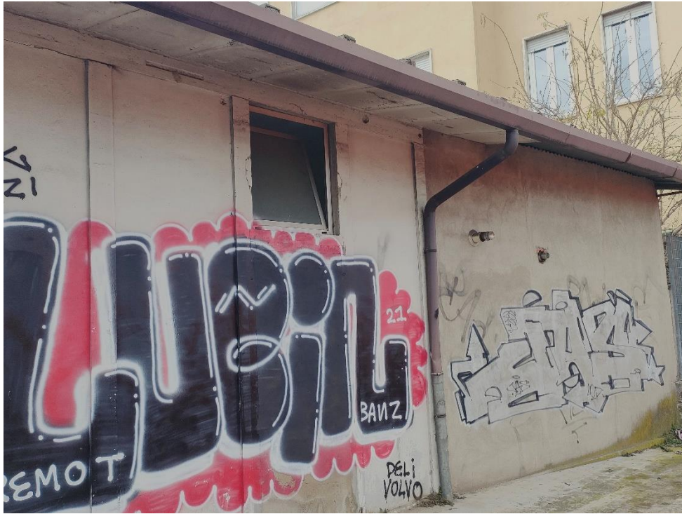
Figura 18 – Fotografia 16: scorcio del prospetto nord
