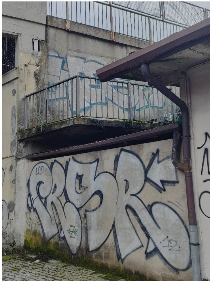
Figura 19 – Fotografia 17: scorcio del prospetto nord
