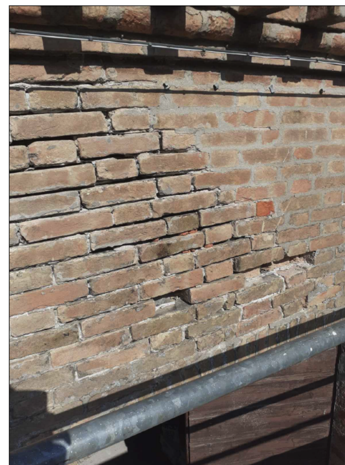
PARAMENTO MURARIO PRIMA DI INTERVENTO DI STILATURA
