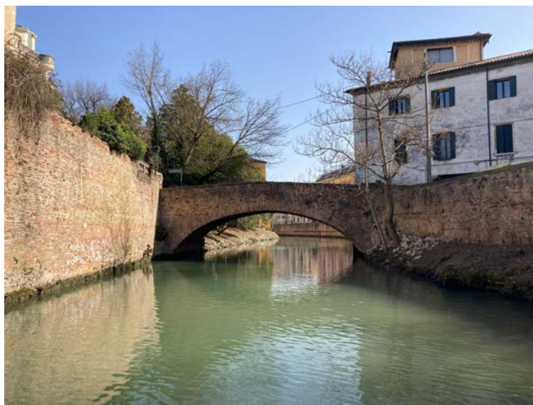
Foto n. 03 – Profilo di monte del Ponte dell'Osservatorio
