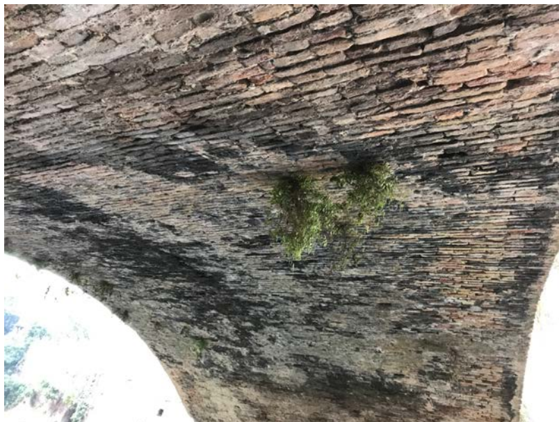
Foto n. 06 – Intradosso della volta
