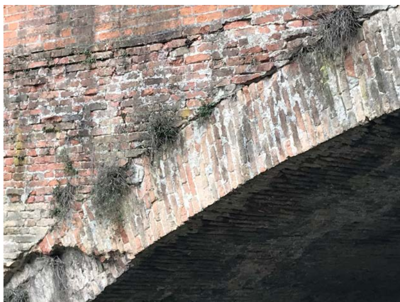
Foto n. 07 – Particolare arcata e timpano prospetto di monte
