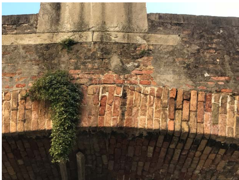
Foto n. 11 – Particolare chiave di volta
