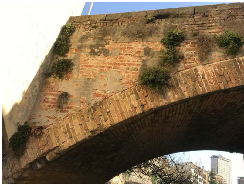
Foto n. 10– Particolare arcata e parapetto laterale
