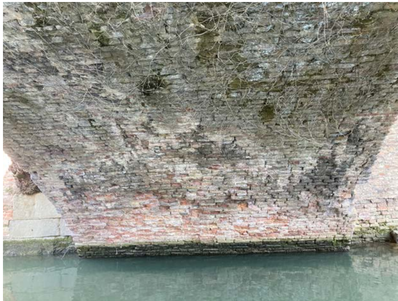
Foto n. 14– Particolare intradosso della volta
