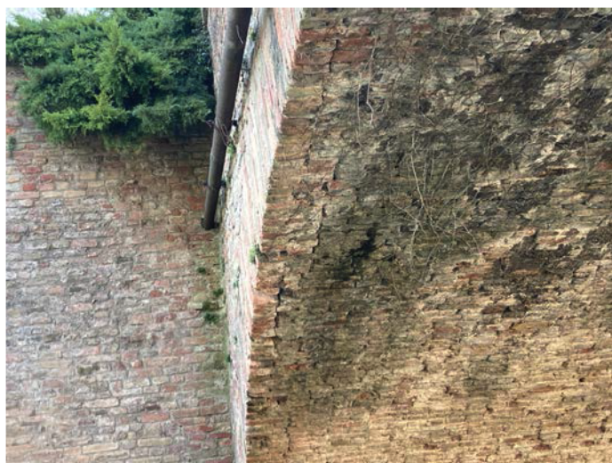
Foto n. 13 – Particolare dell'arcata e intradosso della volta
