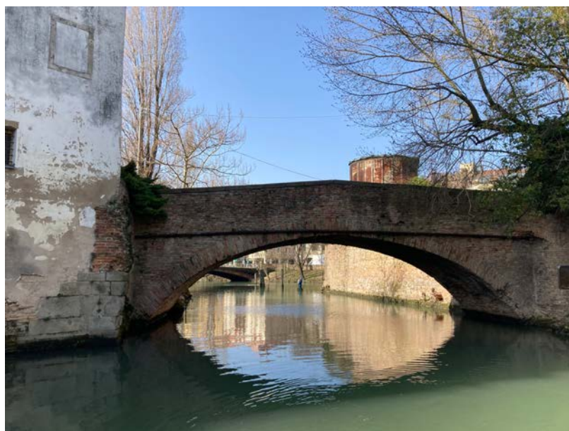
Foto n. 12 – Prospetto di valle
