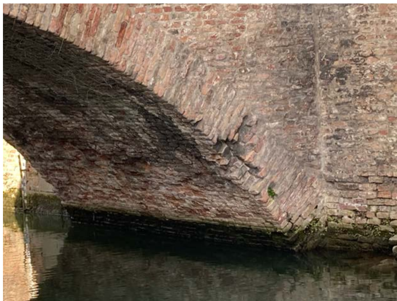
Foto n. 15 – Particolare arcata di valle
