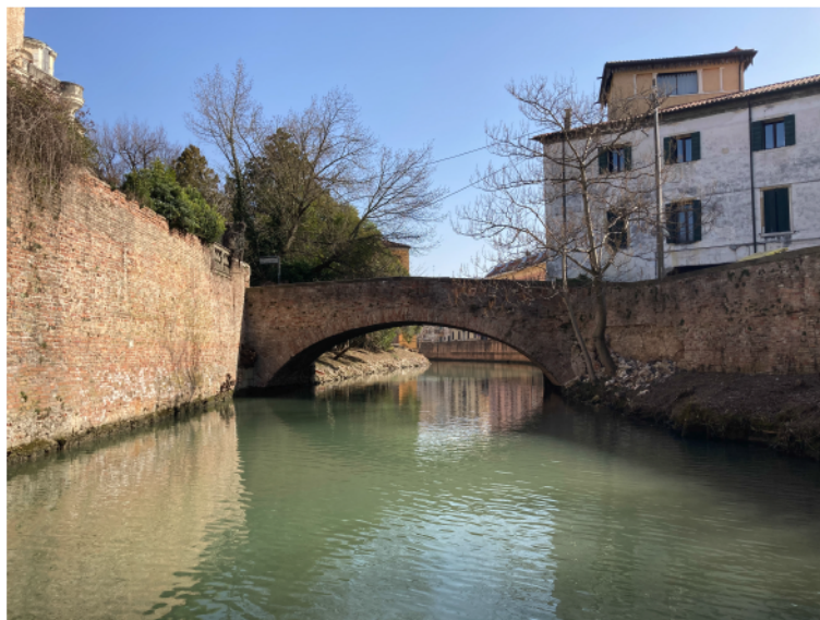
Foto n. 03 – Profilo di monte del Ponte dell'Osservatorio
