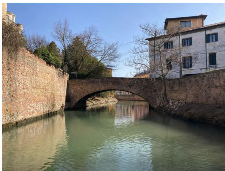
Foto n. 03 – Profilo di monte del Ponte dell'Osservatorio
