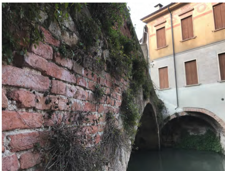
Foto n. 05 – Paramento di valle
