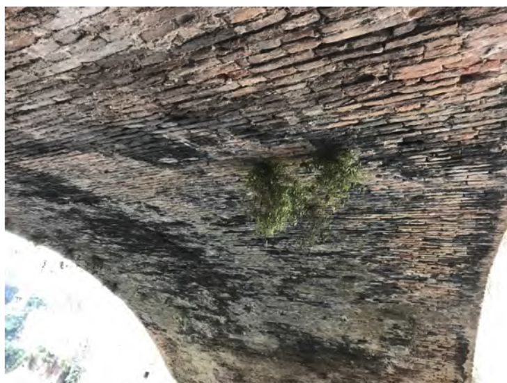
Foto n. 06 – Intradosso della volta
