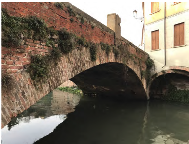
Foto n. 04 – Vista prospettica di valle
