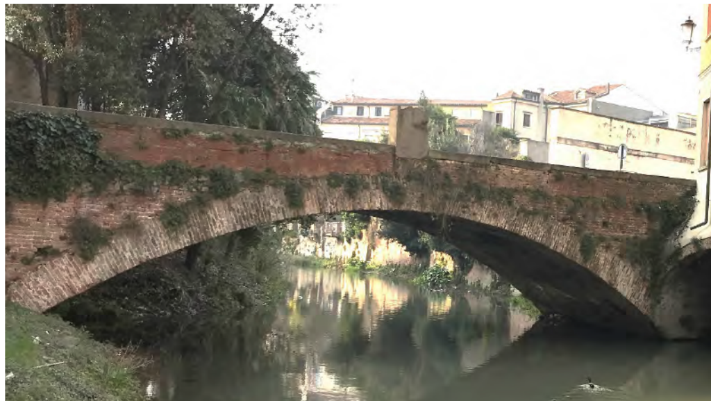
Fig. 1 Vista da Valle.
