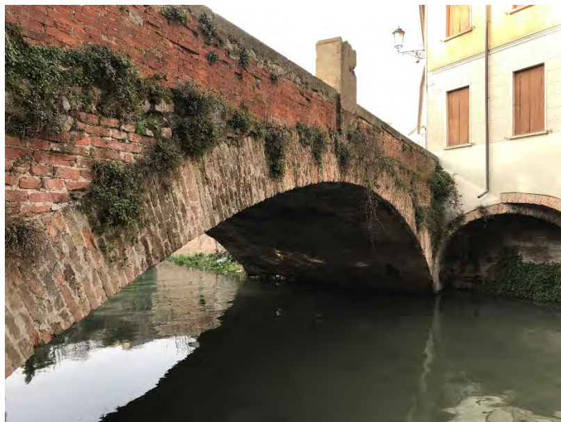
Foto 02 – Volta in sinistra idraulica
