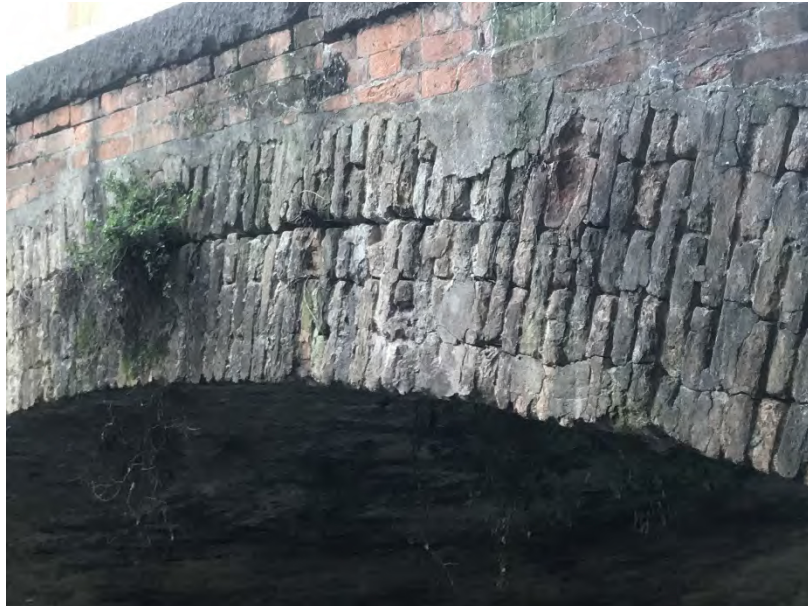
Foto 07 – Particolare arco volta lat di monte
