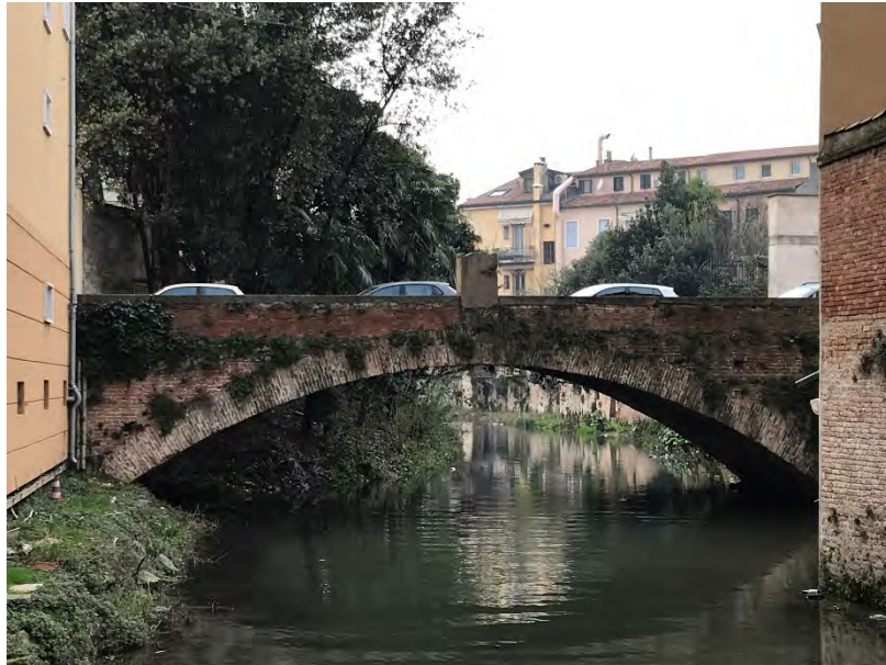
Foto 01 – Prospetto di Monte
