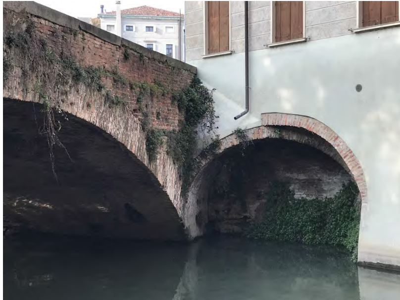
Foto 03 – Spalla in sinistra idraulica lato di monte
