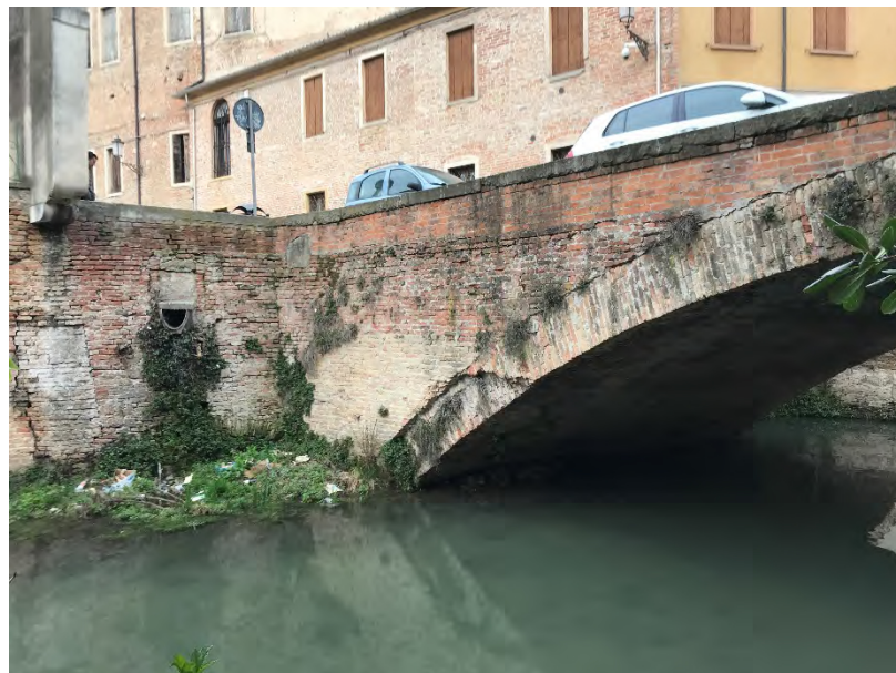
Foto 04 – Spalla in sinistra idraulica lato di valle
