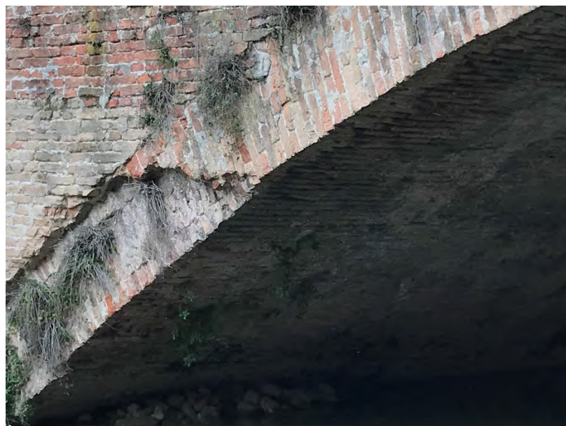
Foto 06 – Particolare volta in sinistra idraulica lato di valle
