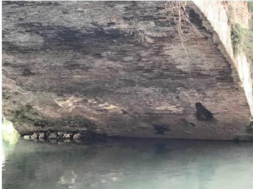
Foto 05 – Intradosso della volta
