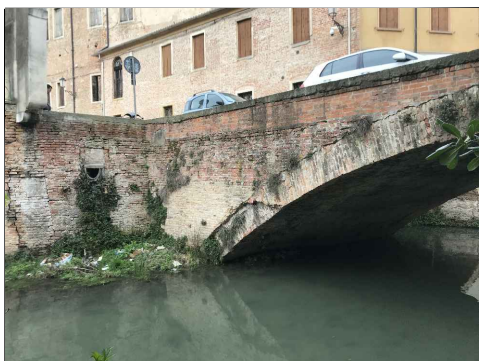
FOTO 5 - Spalla in sinistra di valle
