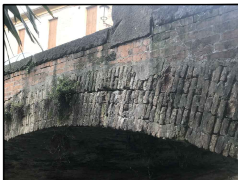
FOTO 6 - Particolare arco volta lato di monte
