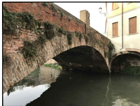
FOTO 3 - Volta in sinistra idraulica
