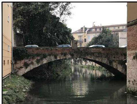
FOTO 2 - Prospetto di monte
