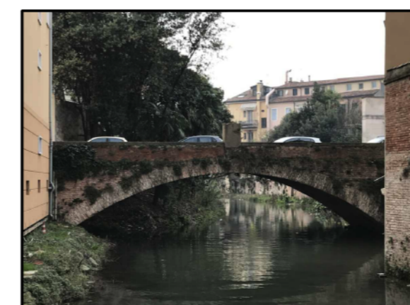
FOTO 2 - Prospetto di monte
