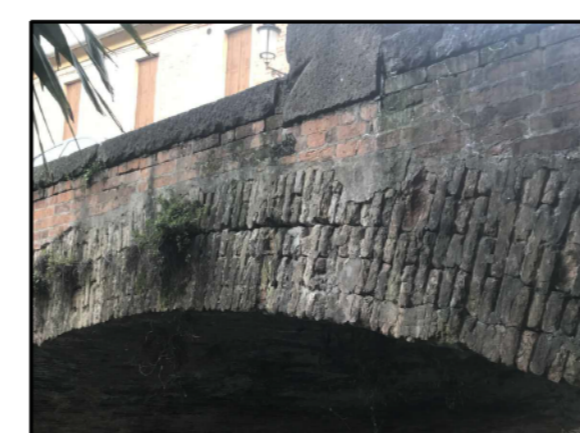
FOTO 6 - Particolare arco volta lato di monte
