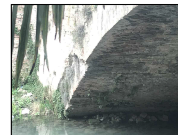
FOTO 8 - Particolare spalla di valle
