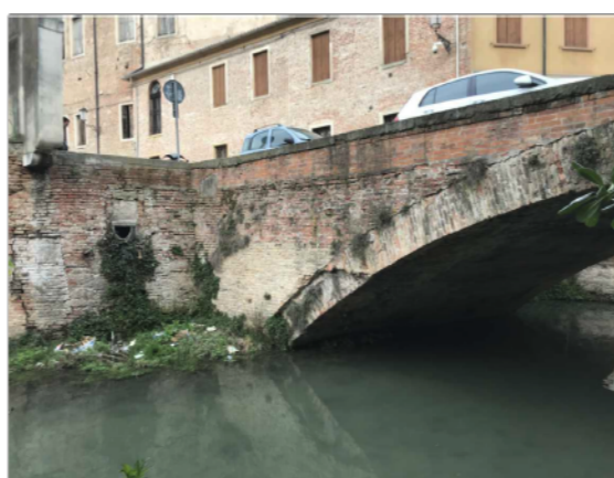
FOTO 5 - Spalla in sinistra di valle
