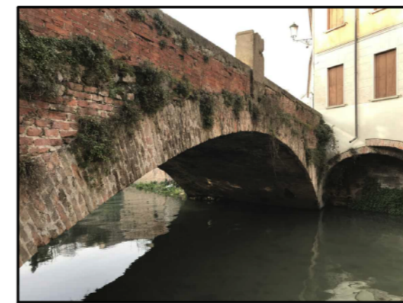
FOTO 3 - Volta in sinistra idraulica
