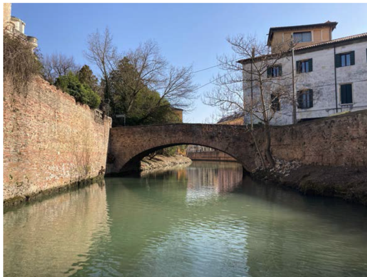
Foto n. 03 – Profilo di monte del Ponte dell'Osservatorio
