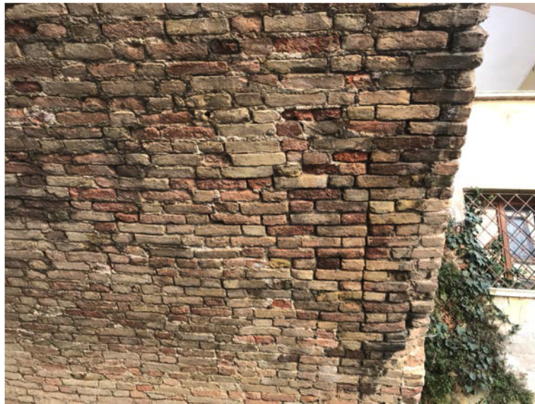
Foto n. 06 – Particolare intradosso della volta
