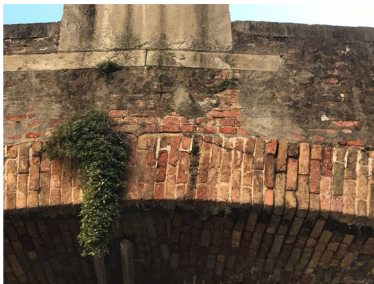
Foto n. 08 – Particolare chiave di volta
