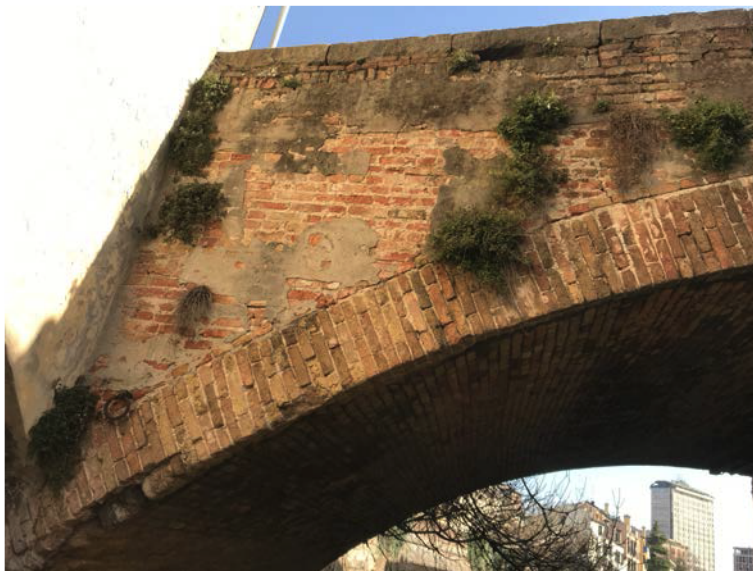
Foto n. 07 – Particolare arcata e parapetto laterale
