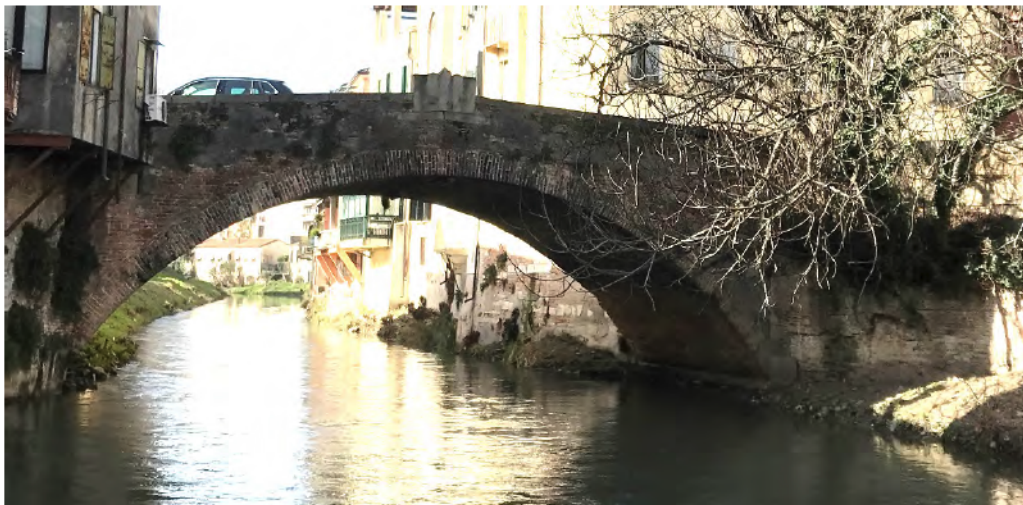
Fig. 1 Vista da Valle.
