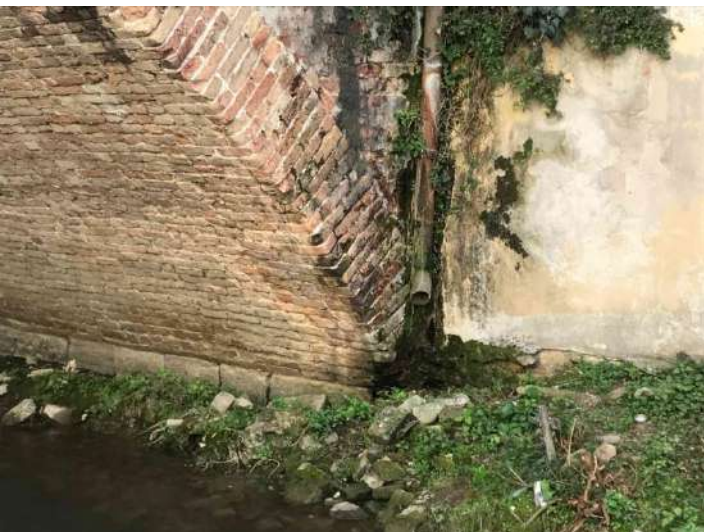
F01: Arcata e spalla a monte
