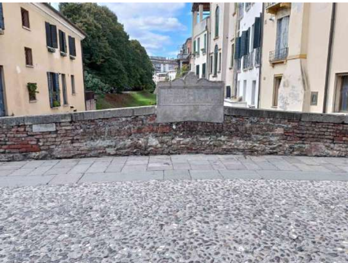
F11: parapetto interno a monte
