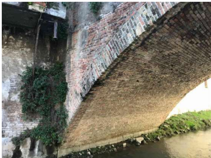
F02: Arcata e spalla a valle
