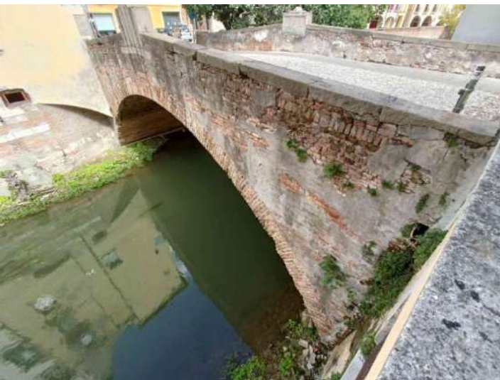
F07: Vista laterale ponte a monte
