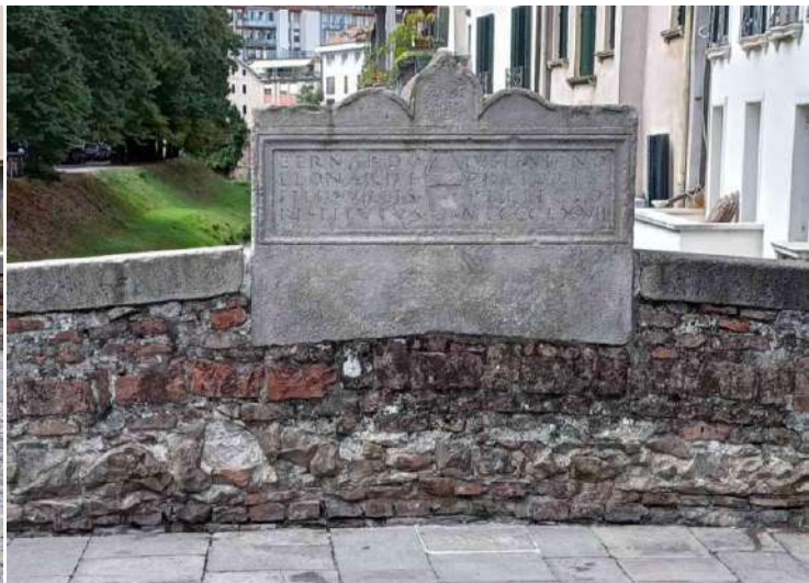
F12: parapetto interno a monte
