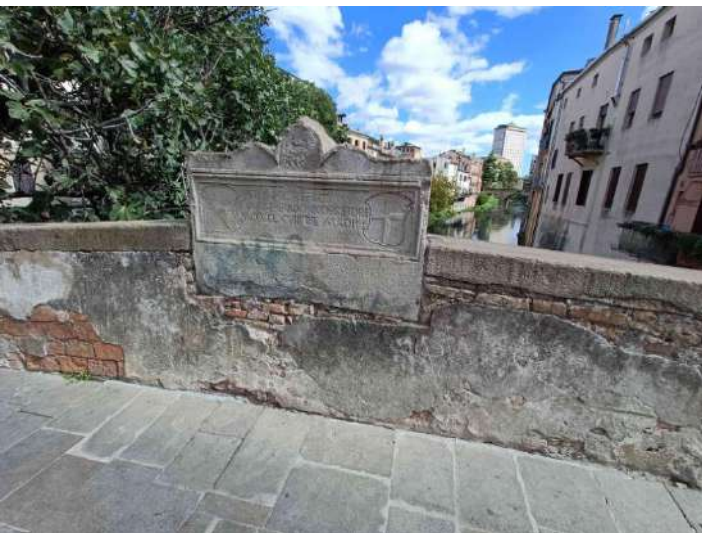
F13: parapetto interno a valle
