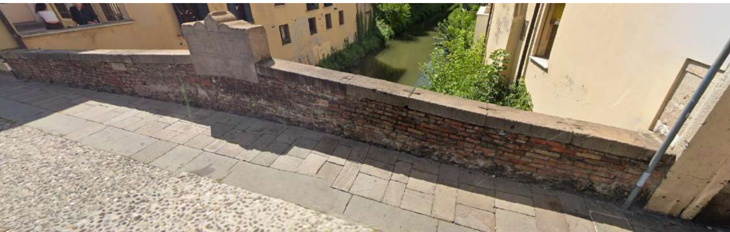
F09: vista d'insieme parapetto interno a monte
