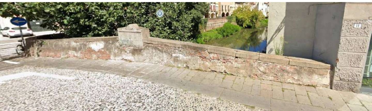
F10: vista d'insieme parapetto interno a valle
