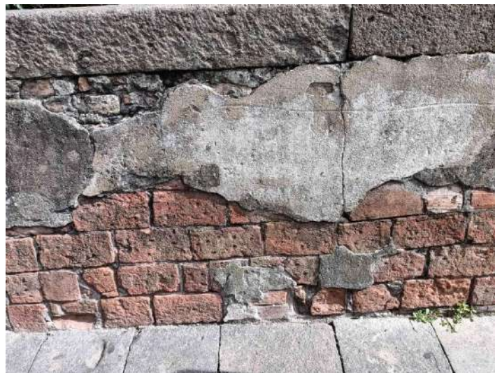
F14: parapetto interno a valle – dettaglio mattoni in foglia
