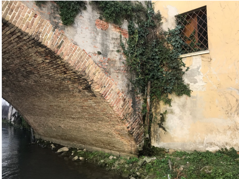
Foto 03 – Particolare spalla in sinistra idraulica lato di Valle
