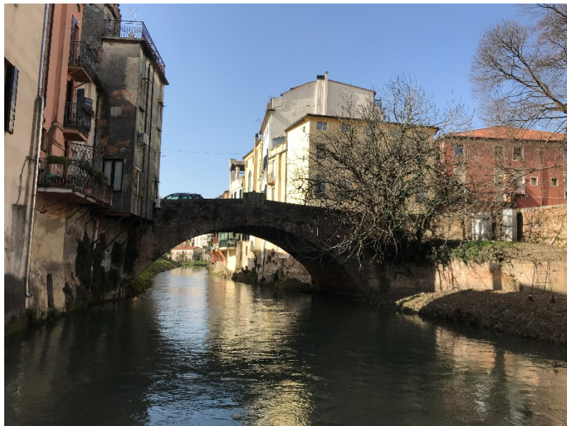
Foto 01 – Prospetto di valle
