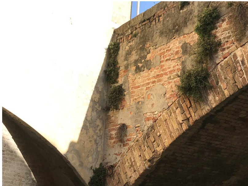
Foto 04 – Particolare spalla e parapetto lato monte
