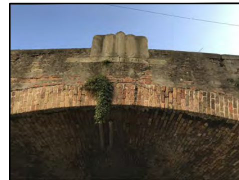
FOTO 4 - Particolare arco e parapetto
