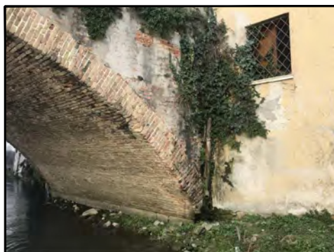
FOTO 6 - Particolare spalla di valle in sinistra
