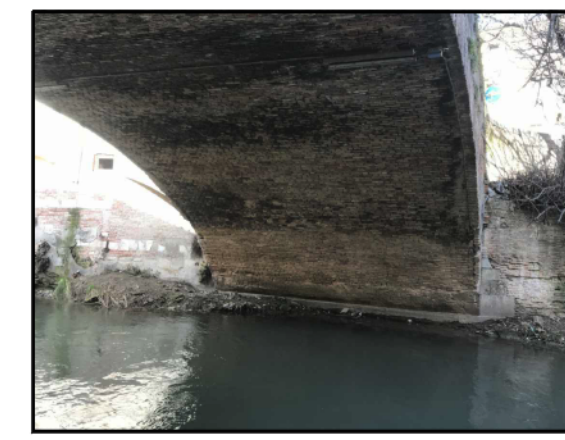
FOTO 2 - Intradosso della volta
