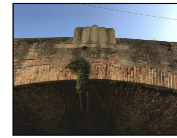
FOTO 4 - Particolare arco e parapetto
