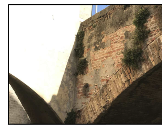
FOTO 5 - Particolare spalla e parapetto
