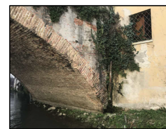
FOTO 6 - Particolare spalla di valle in sinistra
