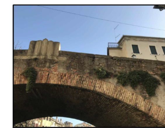
FOTO 7 - Particolare prospetto di monte
