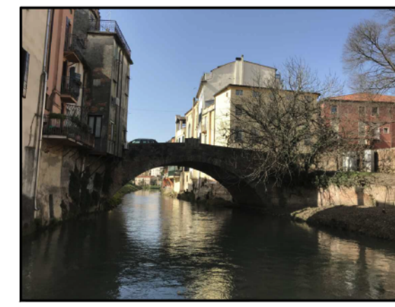
FOTO 1 - Prospetto di Valle
