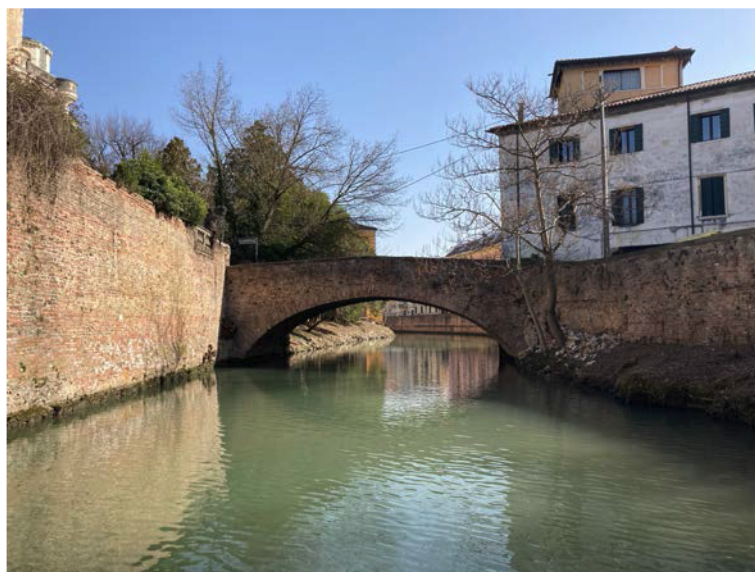
Foto n. 03 – Profilo di monte del Ponte dell'Osservatorio
