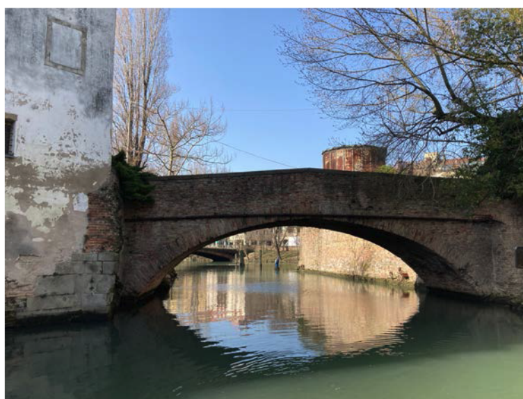
Foto n. 04 – Prospetto di valle
