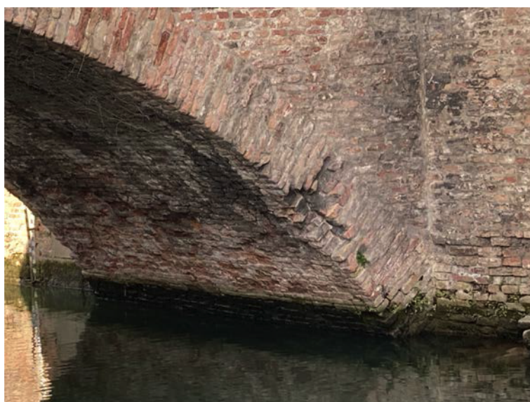
Foto n. 07 – Particolare arcata di valle
