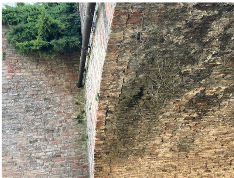
Foto n. 05 – Particolare dell'arcata e intradosso della volta
