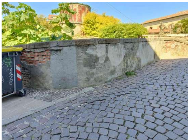
F10: Parapetto intero di monte
