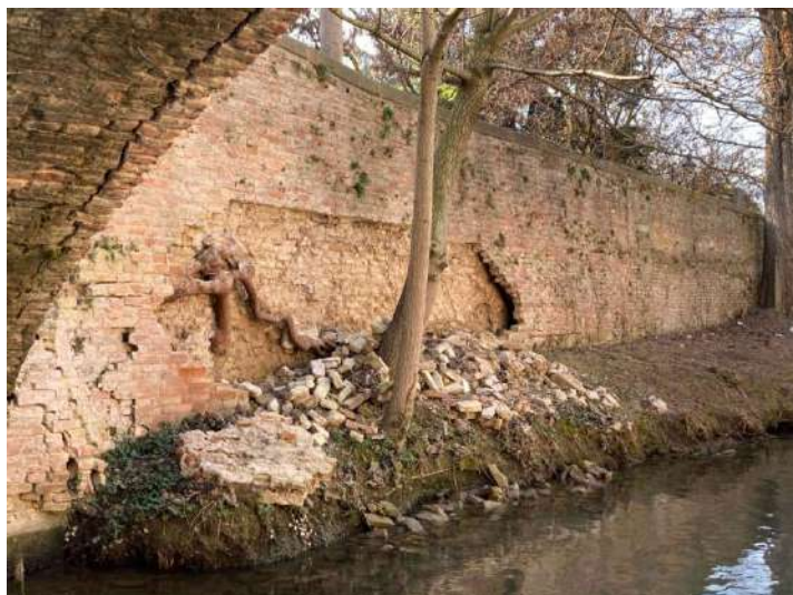
F04: Muro di contenimento di monte
