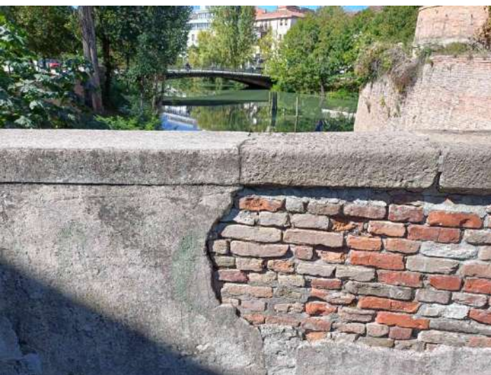
F11: Parapetto intero di monte
