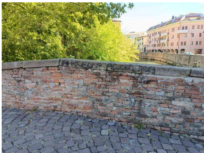
F08: Parapetto interno e copertina di valle
