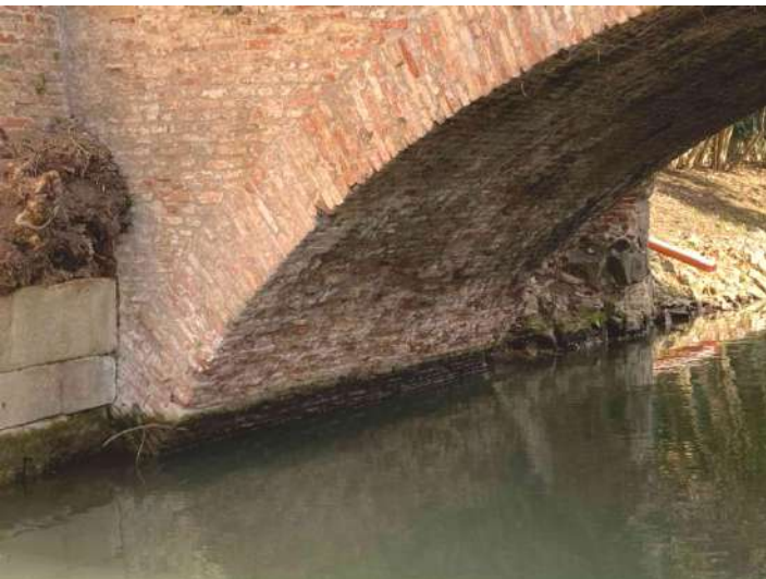
F01: Spalla di valle
