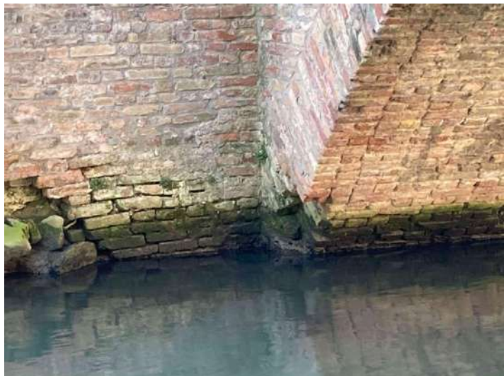
F02: Spalla di monte
