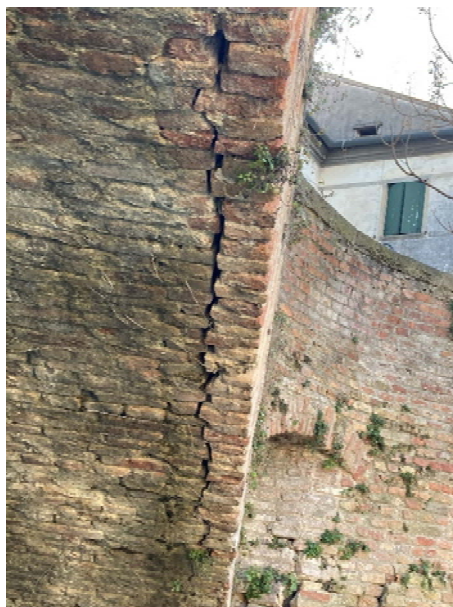
Foto 06 – Particolare volta lato di monte
