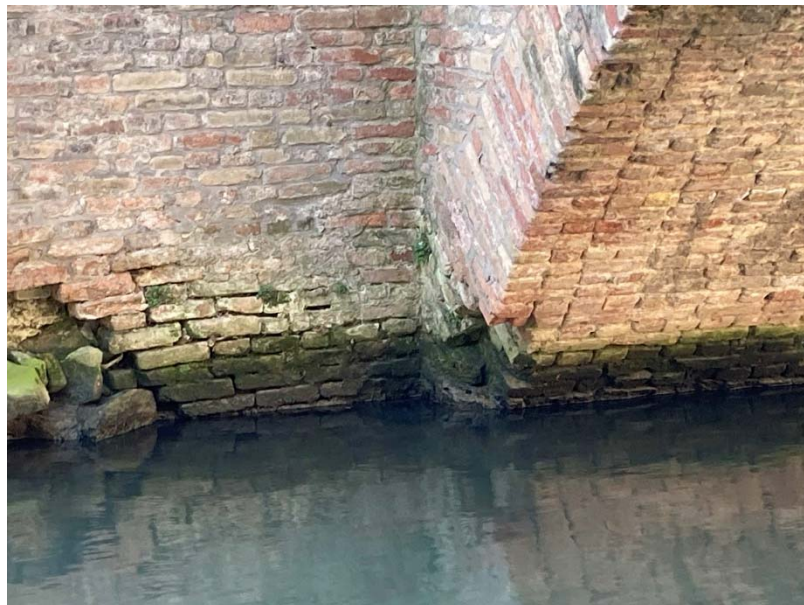
Foto 05 – Particolare spalla in sinistra idraulica lato di monte
