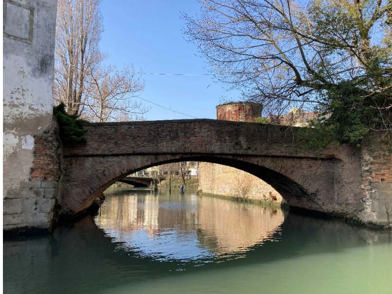
Foto 01 – Prospetto di valle
