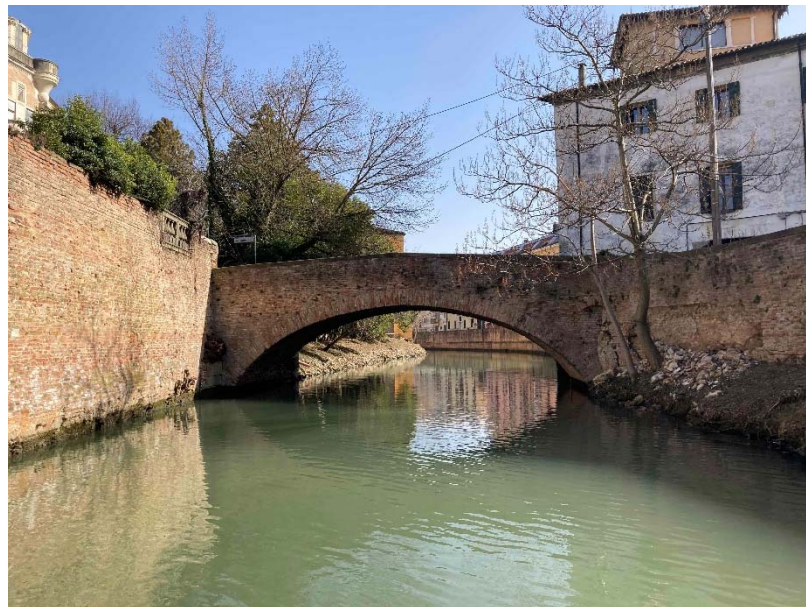
Foto 02 – Prospetto di monte
