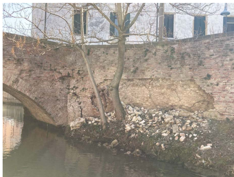
Foto 04 – Particolare spalla in destra idraulica lato di monte
