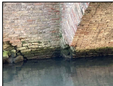
FOTO 7 - Particolare spalla di monte
