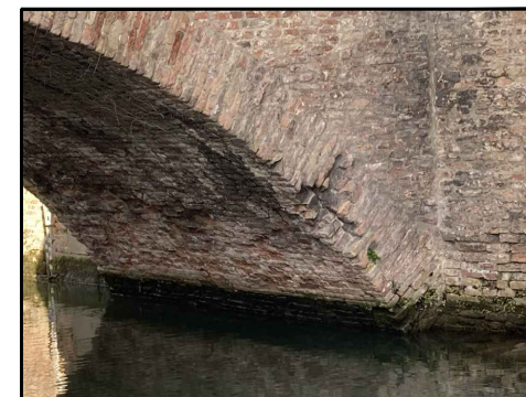
FOTO 8 - Particolare spalla di valle in sinistra
