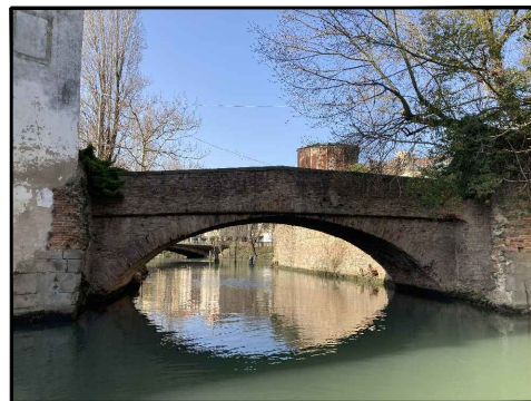
FOTO 2 - Prospetto di valle
