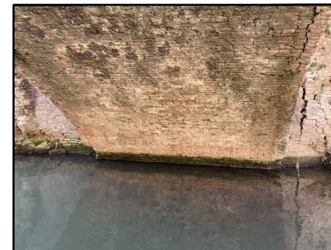
FOTO 4 - Intradosso volta in destra
