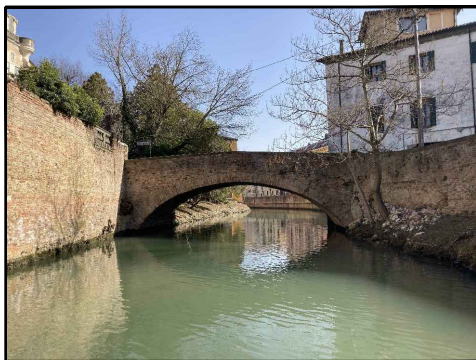
FOTO 1 - Prospetto di monte
