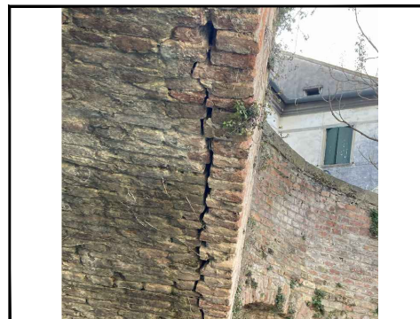
FOTO 3 - Particolare volta di monte
