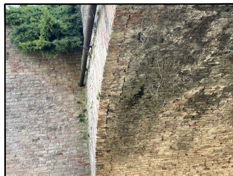
FOTO 6 - Particolare volta di monte in sinistra
