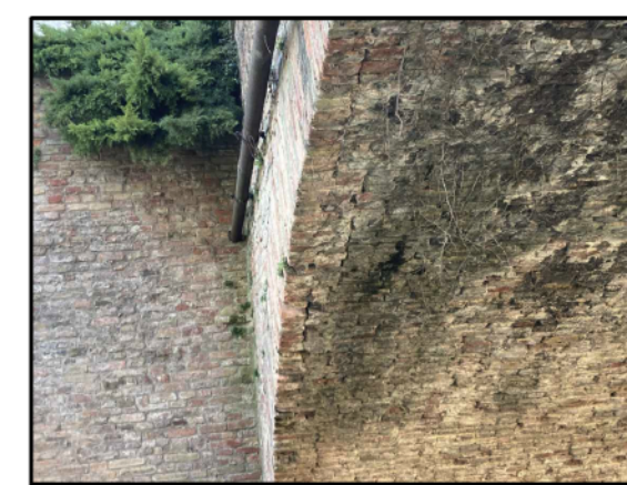
FOTO 6 - Particolare volta di monte in sinistra
