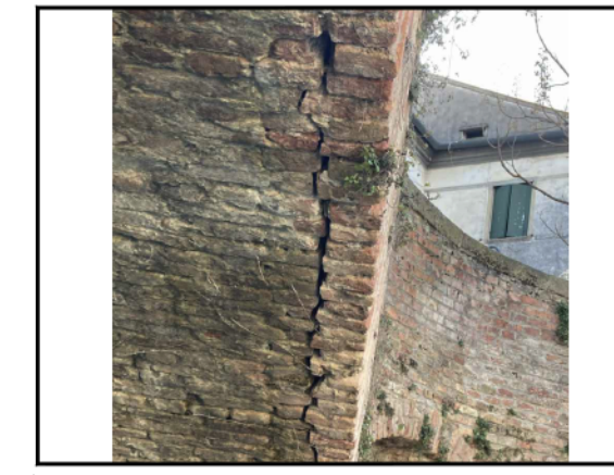
FOTO 3 - Particolare volta di monte
