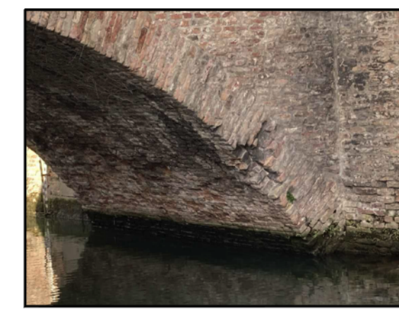
FOTO 8 - Particolare spalla di valle in sinistra
