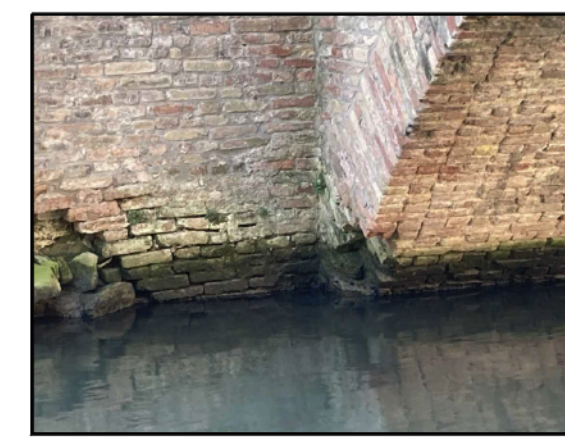
FOTO 7 - Particolare spalla di monte
