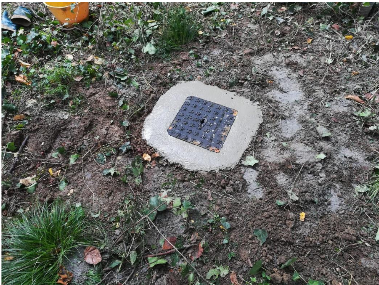
Figura 8 - Pozzetto di protezione del tubo piezometrico posto nel sondaggio Pz_2.
