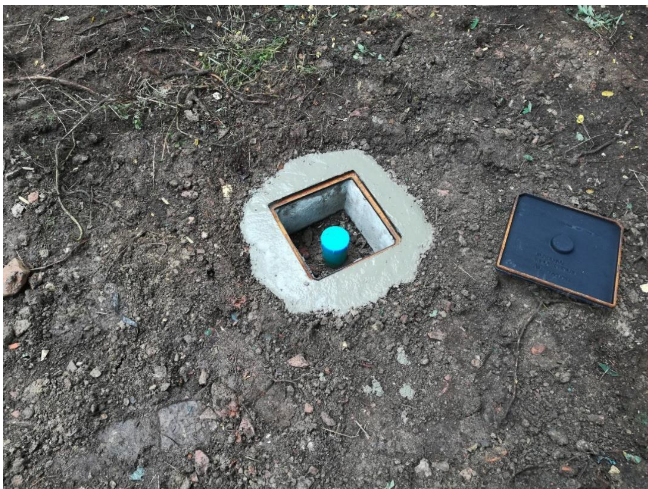
Figura 12 - Pozzetto di protezione del tubo piezometrico posto nel sondaggio Pz_5.
