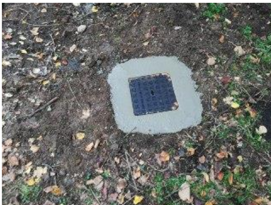
Figura 6 - Pozzetto di protezione del tubo piezometrico posto nel sondaggio Pz_1.
