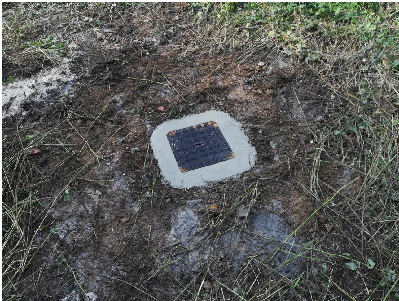
Figura 10 - Pozzetto di protezione del tubo piezometrico posto nel sondaggio Pz_3.
