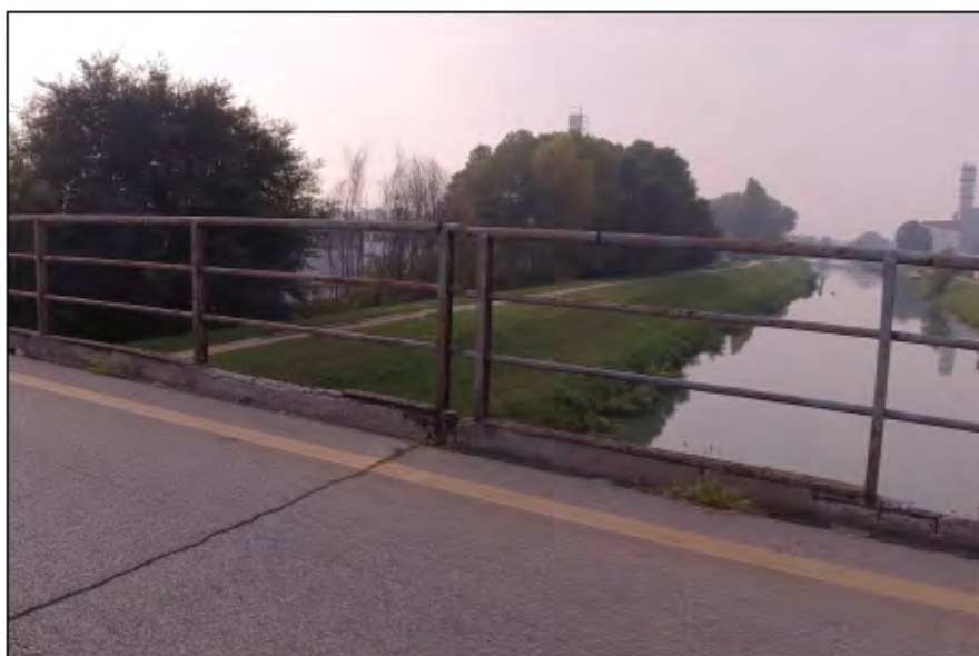
Foto n. 02 – Barriere esistente bordo ponte
