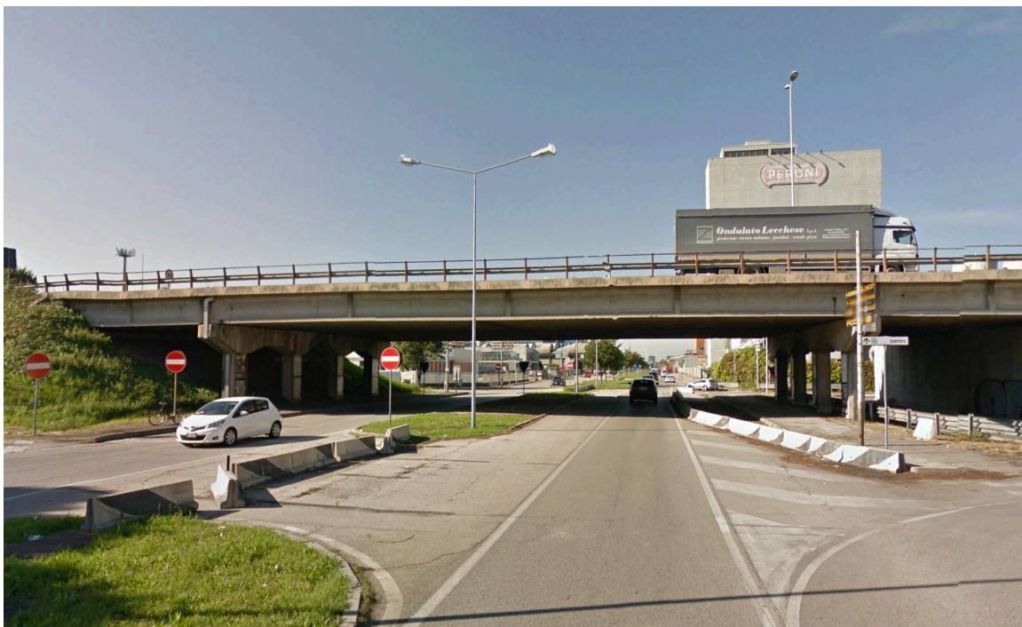
Vista impalcato – Viale dell'Industria
