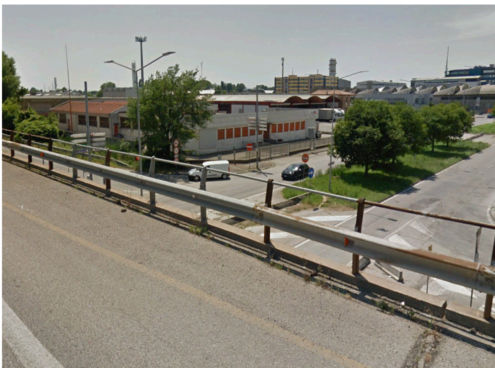
Cordolo esistente su impalcato – Viale dell'Industria
