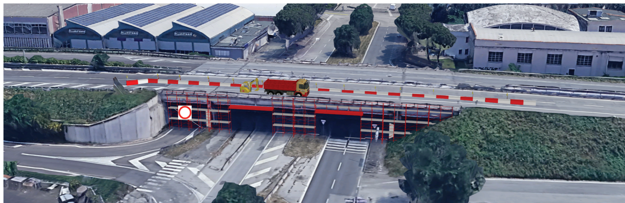
ALLESTIMENTO PONEGGI PER IMPALCATO SU VIALE INDUSTRIA
