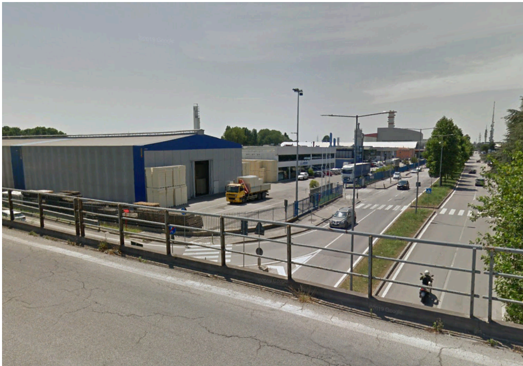
Cordolo esistente su impalcato – Viale della Navigazione Interna
