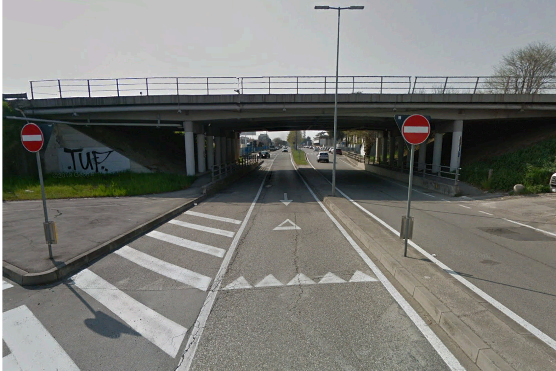
Vista impalcato – Viale della Navigazione Interna
