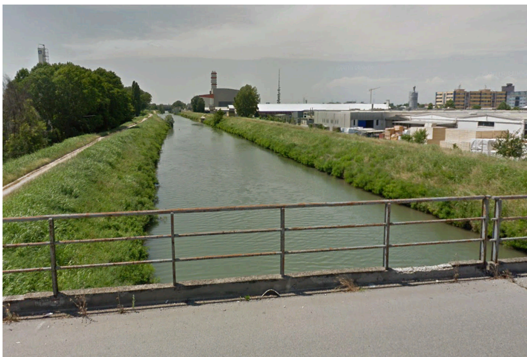
Cordolo esistente su impalcato – Ponte sul Piovego
