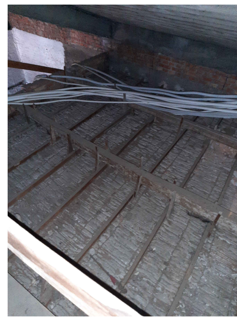
Foto stato di fatto tubazioni esistenti
