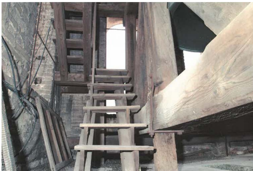
Fig. 3 Rampa di accesso al ballatoio di sommità
