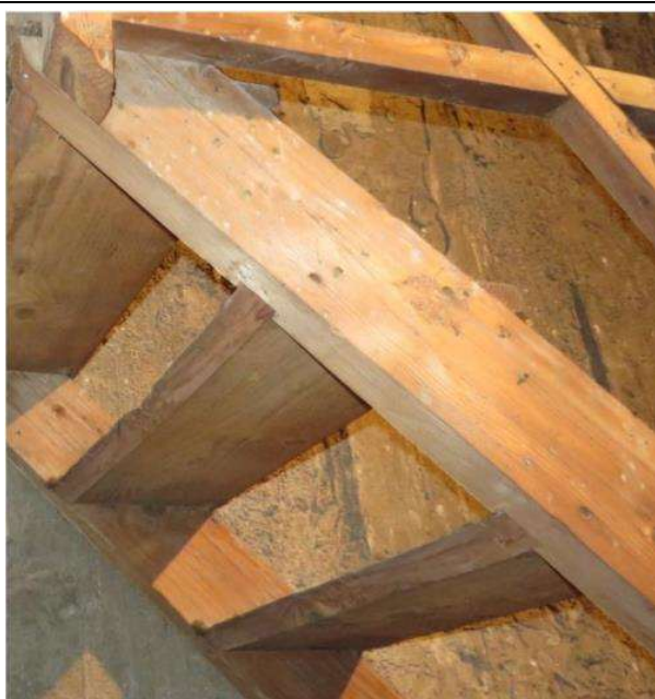
Particolare di una delle rampe
