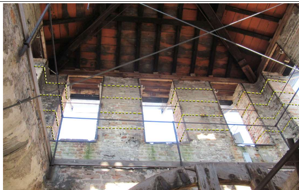
Fasciatura dei merli in copertura con barre inox inserite a scomparsa nei giunti di malta
