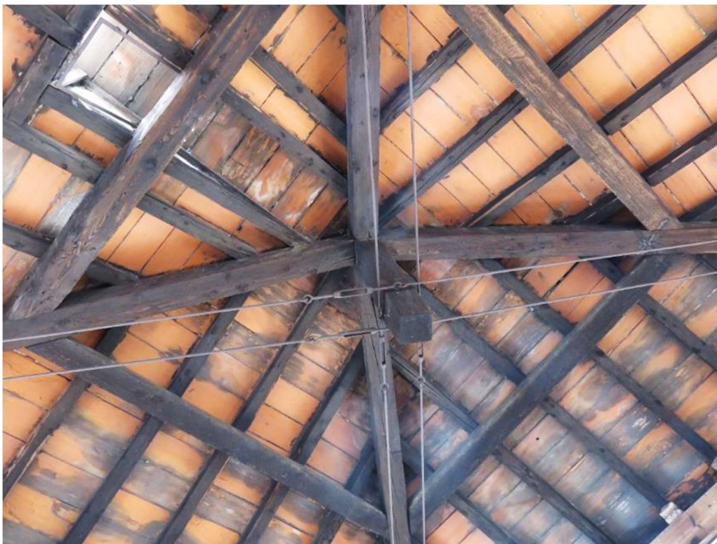
Particolare della copertura lignea
