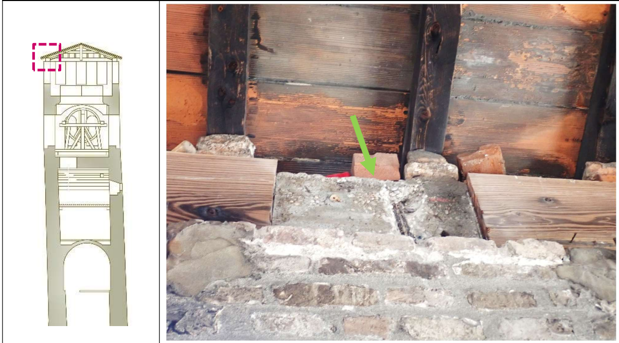
Particolare del cordolo in c.a. evidenziato dalle indagini
