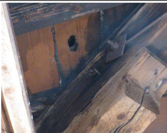
Particolari di degrado dei tavelloni forati in laterizio (si tratta di elementi "moderni" di tipo estruso)
