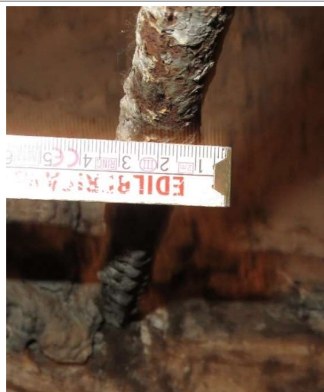
Particolari catene e barre trasversali di confinamento delle murature inserite nel 1938-40. Sulle pareti sono visibili le tracce delle iniezioni di boiacche cementizie.
