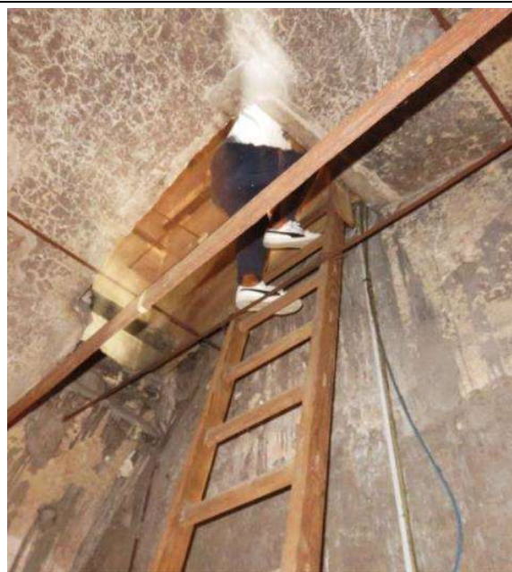
Particolare scala per l'accesso alla volta V4
