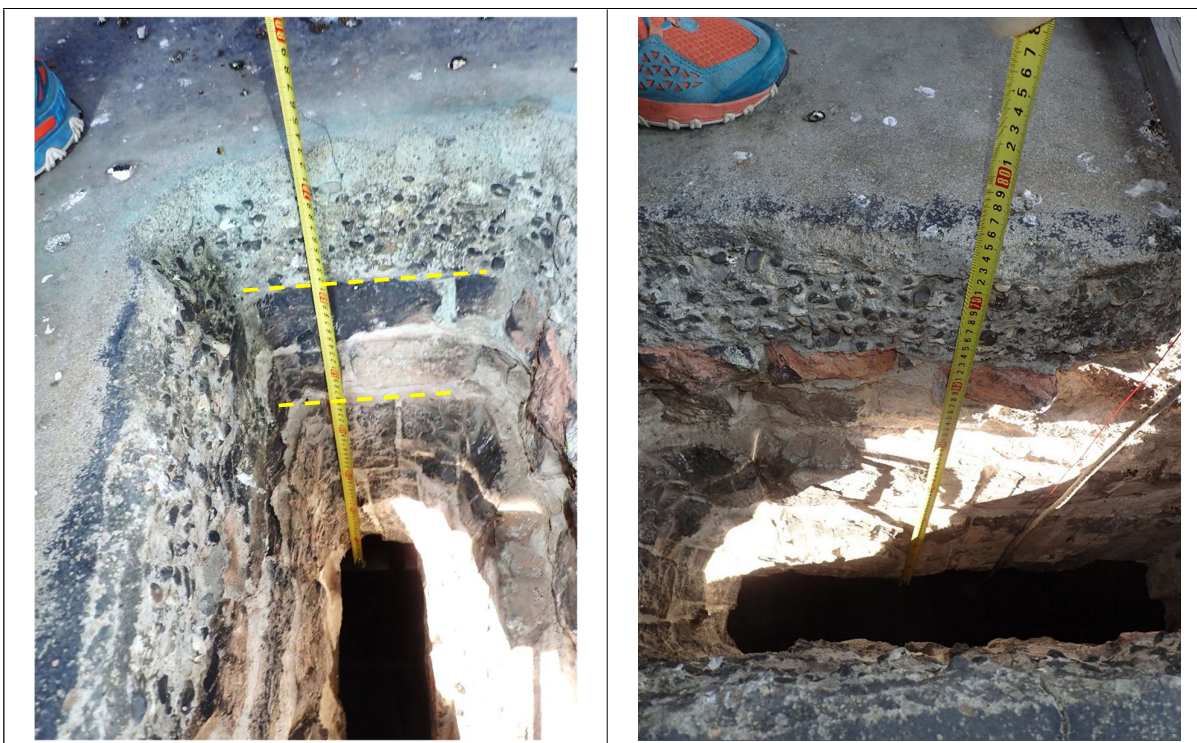
Particolari della struttura della volta attraverso il foro esistente
