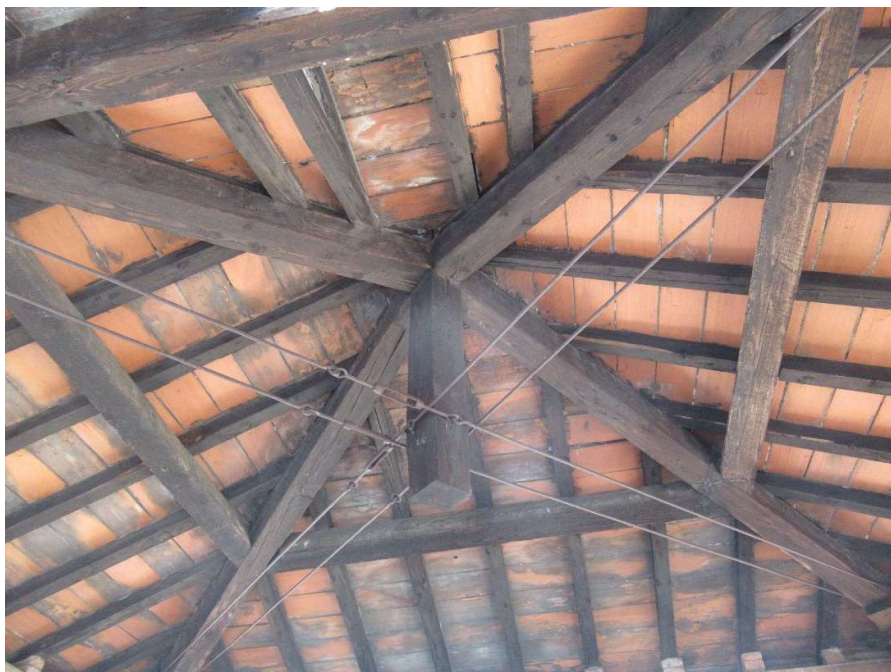
Figura 1 – Vista della copertura esistente
