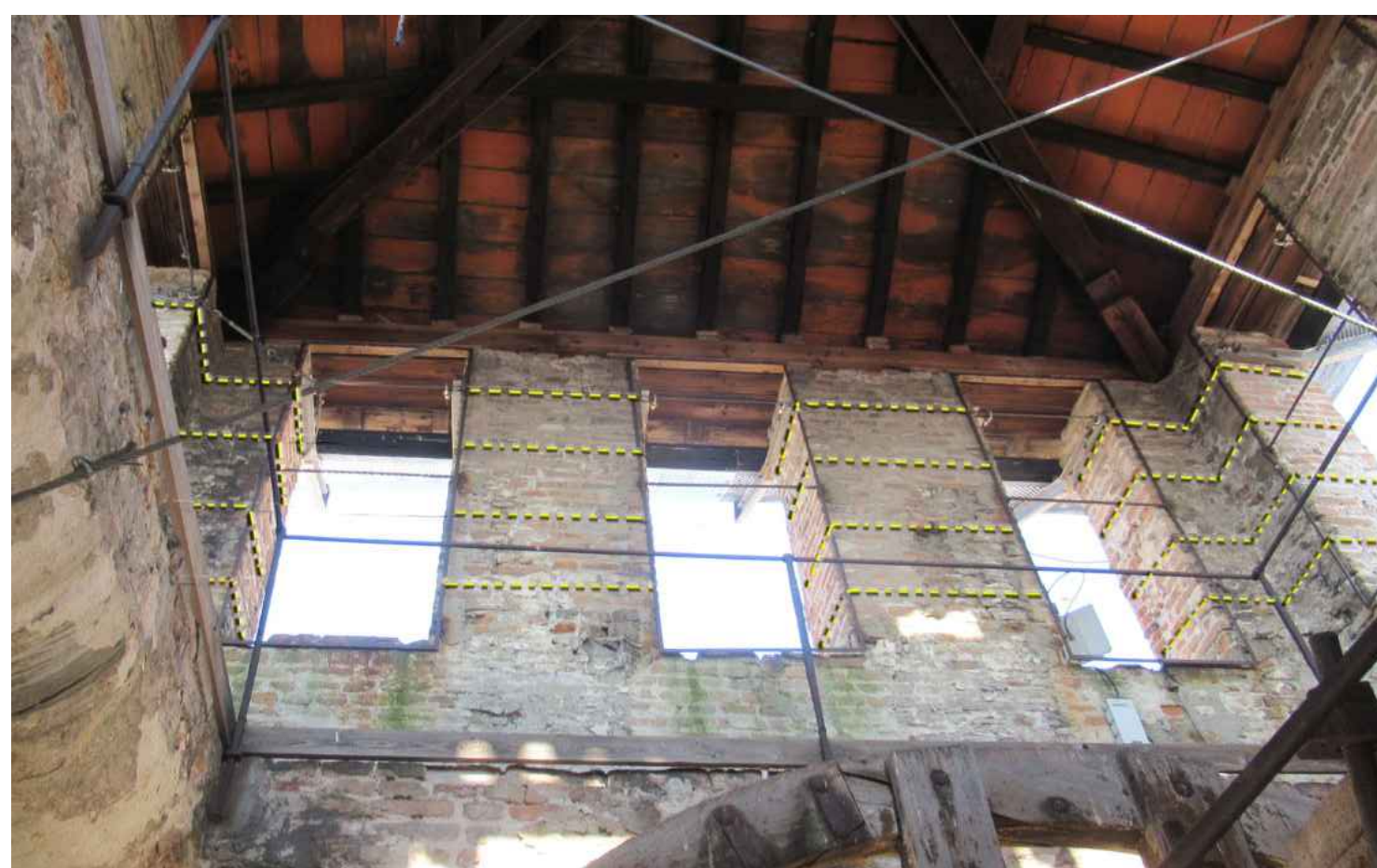
DETTAGLIO 1: CONSOLIDAMENTO MERLATURE
