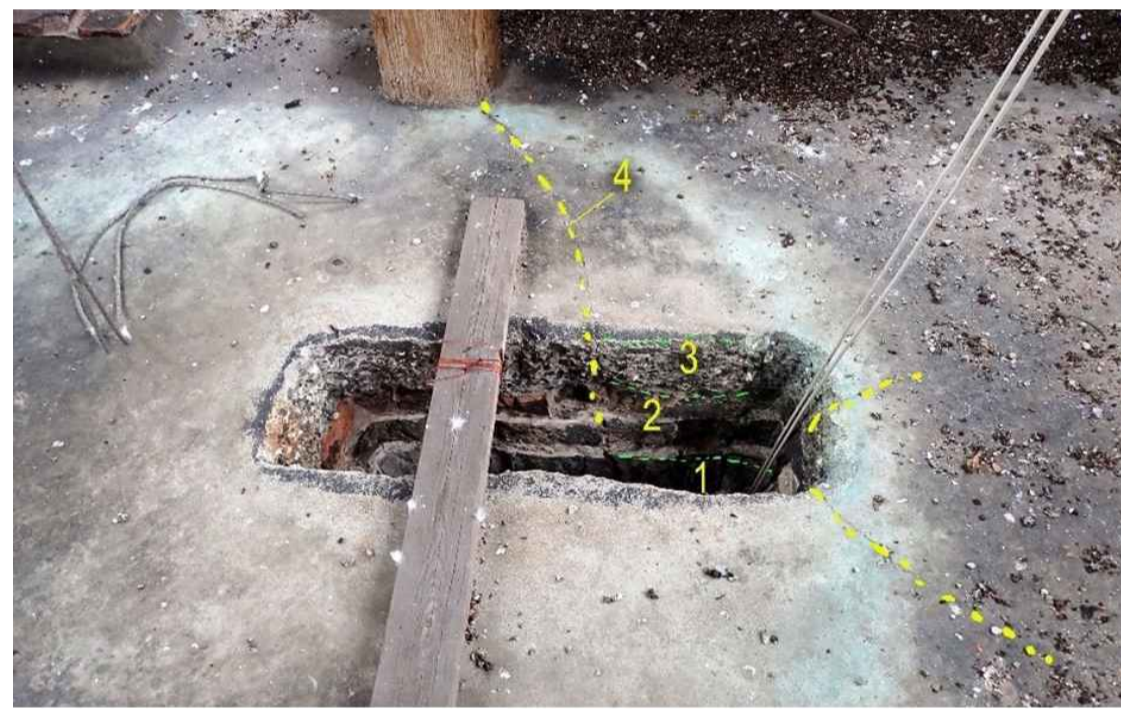
Nella foto particolare del solettone di grosso spessore in cls (3) presumibilmente non armato che presenta una rete di fessurazioni (4). Al di sotto si può notare la volta in laterizio (1) ed il materiale di riempimento (2).
