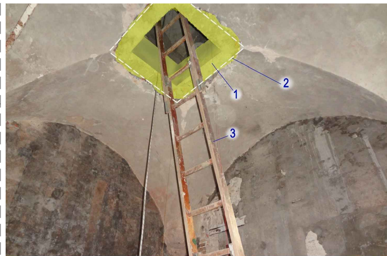
Nella foto particolare del solettone di grosso spessore in cls (3) presumibilmente non armato che presenta una rete di fessurazioni (4). Al di sotto si può notare la volta in laterizio (1) ed il materiale di riempimento (2).
