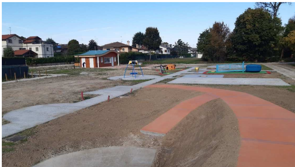
Vista da sud del nuovo parco e delle opere già realizzate con i lotti precedenti
