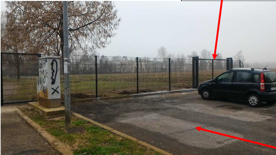
Sottoterra è presente l'impianto di sollevamento delle fognatura di gestione a cura di Aps
