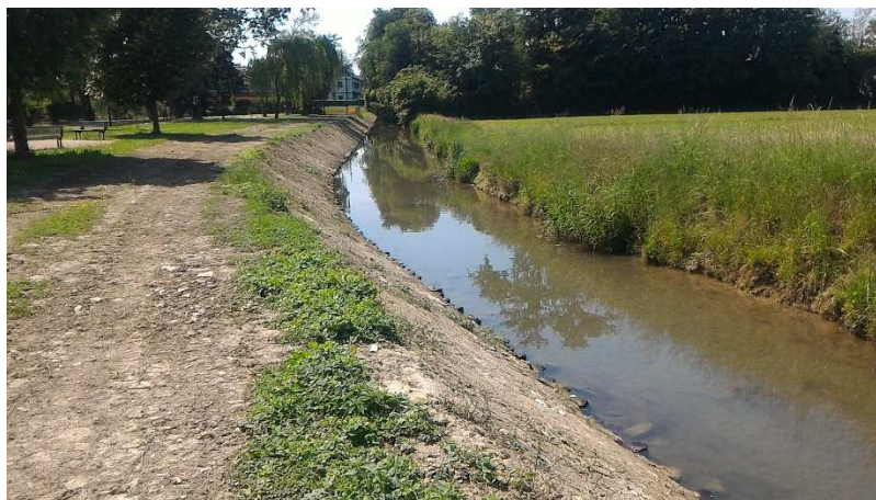
Vista dall'ingresso da Via Siena del canale Boschette
