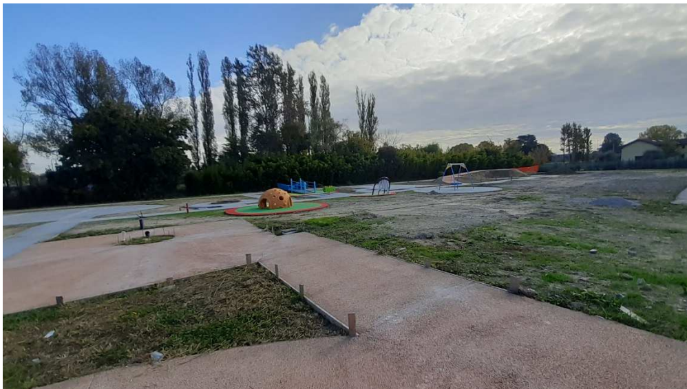
Sulla destra l’area ove andrà costruito il Fabbricato Aggregazione e la pergola bioclimatica con relativa pavimentazione: l’area perimetrale andrà segregata
