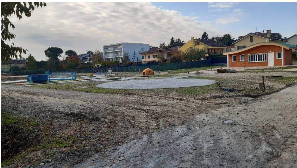
Ingresso al nuovo parco: si nota in primo piano un'area gioco ed in secondo piano il fabbricato "ristoro-servizi"
