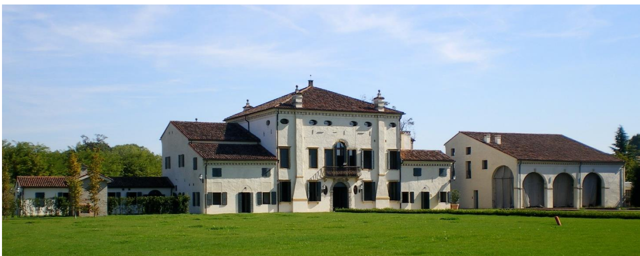
Villa Zaguri – fronte principale, prospetto ovest
