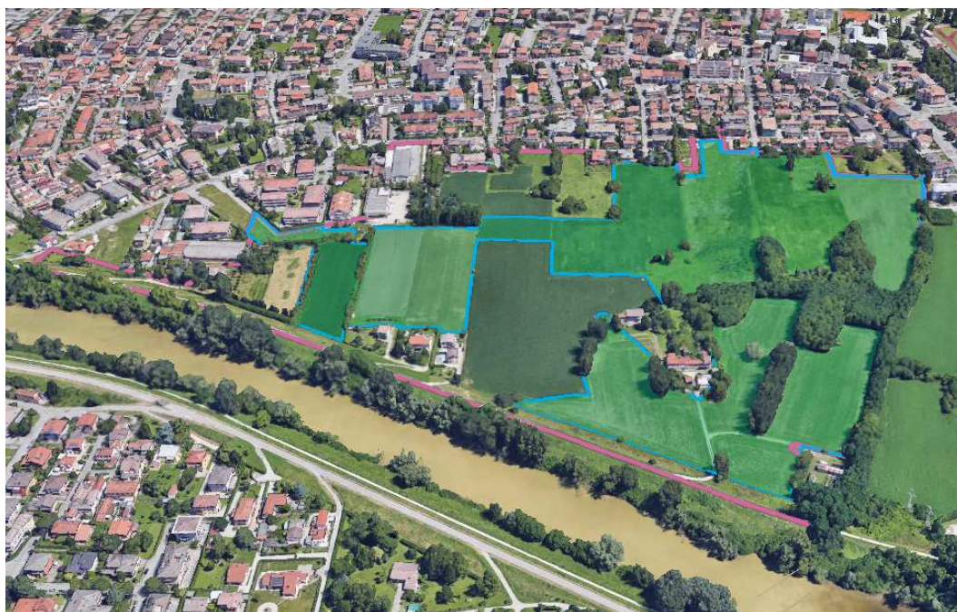
Figura 6.1 - Perimetrazione zona di perequazione ambientale n.7 e PUA Isola di Torre su immagine satellitare. Elaborazione dati su Google Earth.
