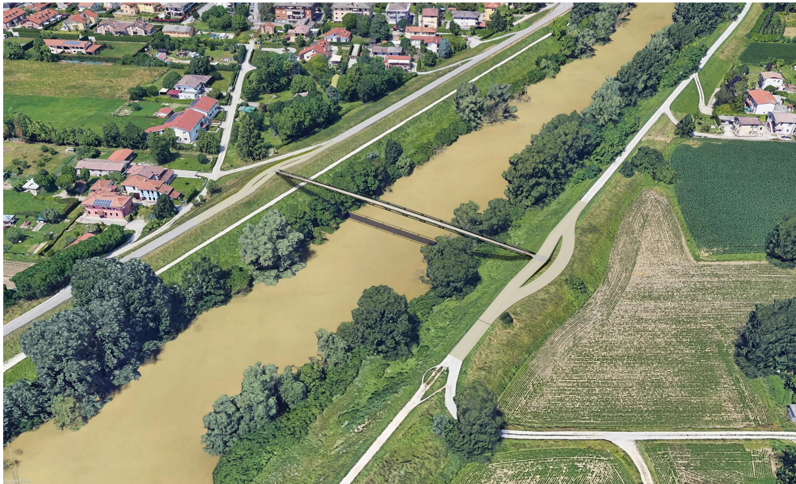
Figura 4 - vista verso ovest (da sponda sinistra)
