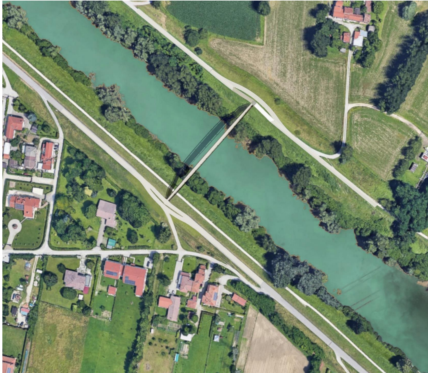
Figura 2 - vista zenitale della passerella - si notano i ringrossi arginali
