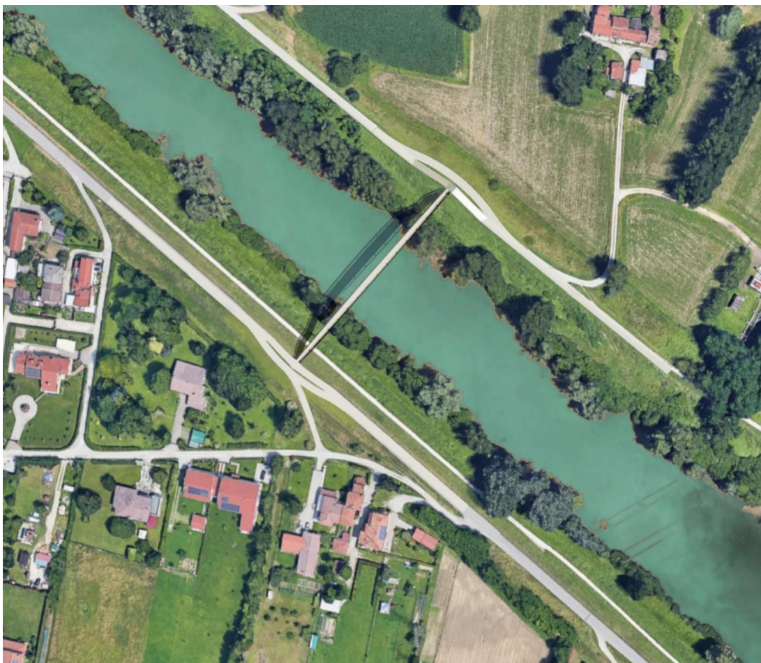
vista zenitale della passerella - si notano i ringrossi arginali
