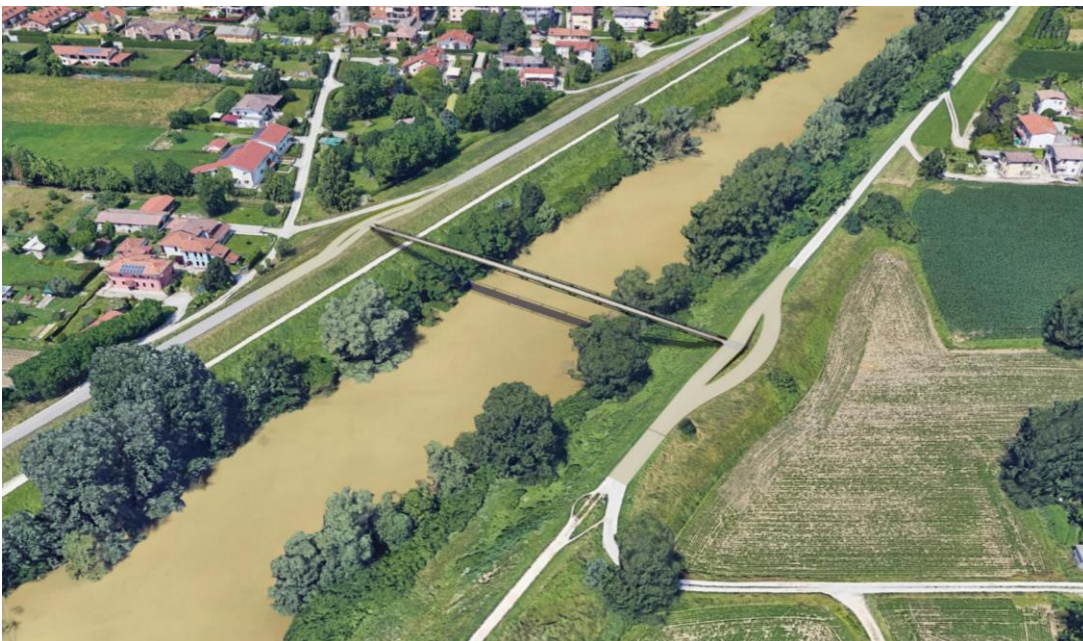
vista verso ovest (da sponda sinistra)
