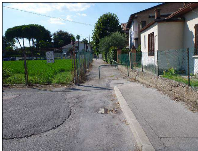
Figura 20. Stato attuale tratto stradale di via Guglielmo Ongarello oggetto di allargamento; vista in direzione nord-ovest.
