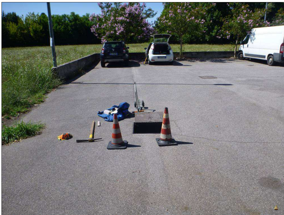
Figura 24. Chiusino in ghisa afferente il pozzetto di ispezione delle acque meteoriche presente in via Jacopo Cavacio; vista in direzione nord-ovest.
