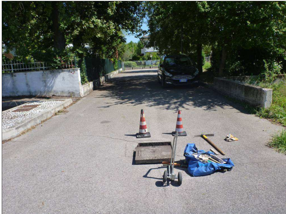
Figura 25. Chiusino in ghisa afferente il pozzetto di ispezione delle acque meteoriche presente in via Jacopo Cavacio; vista in direzione sud-est.
