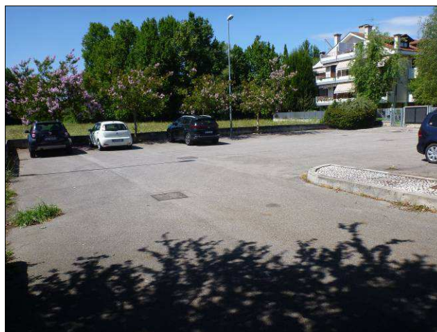
Figura 8. Stato attuale parcheggio pubblico oggetto di ampliamento; vista in direzione nord-ovest.
