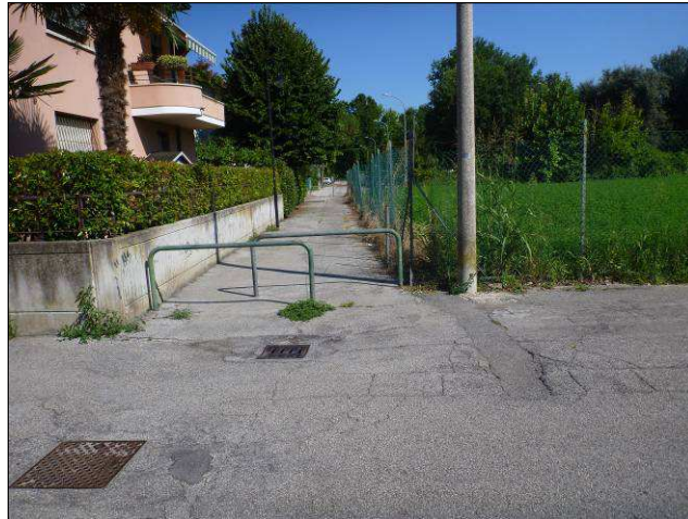
Figura 19. Stato attuale tratto stradale di via Guglielmo Ongarello oggetto di allargamento; vista in direzione sud-est.
